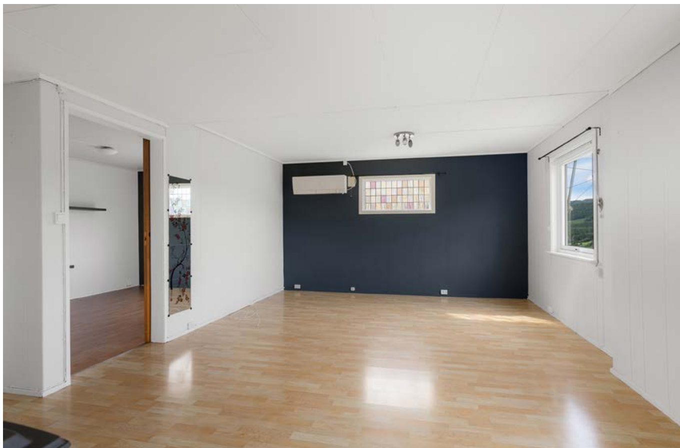
Stuen er utstyrt med en luft-til-luft varmepumpe fra 2019 for effektiv oppvarming.
