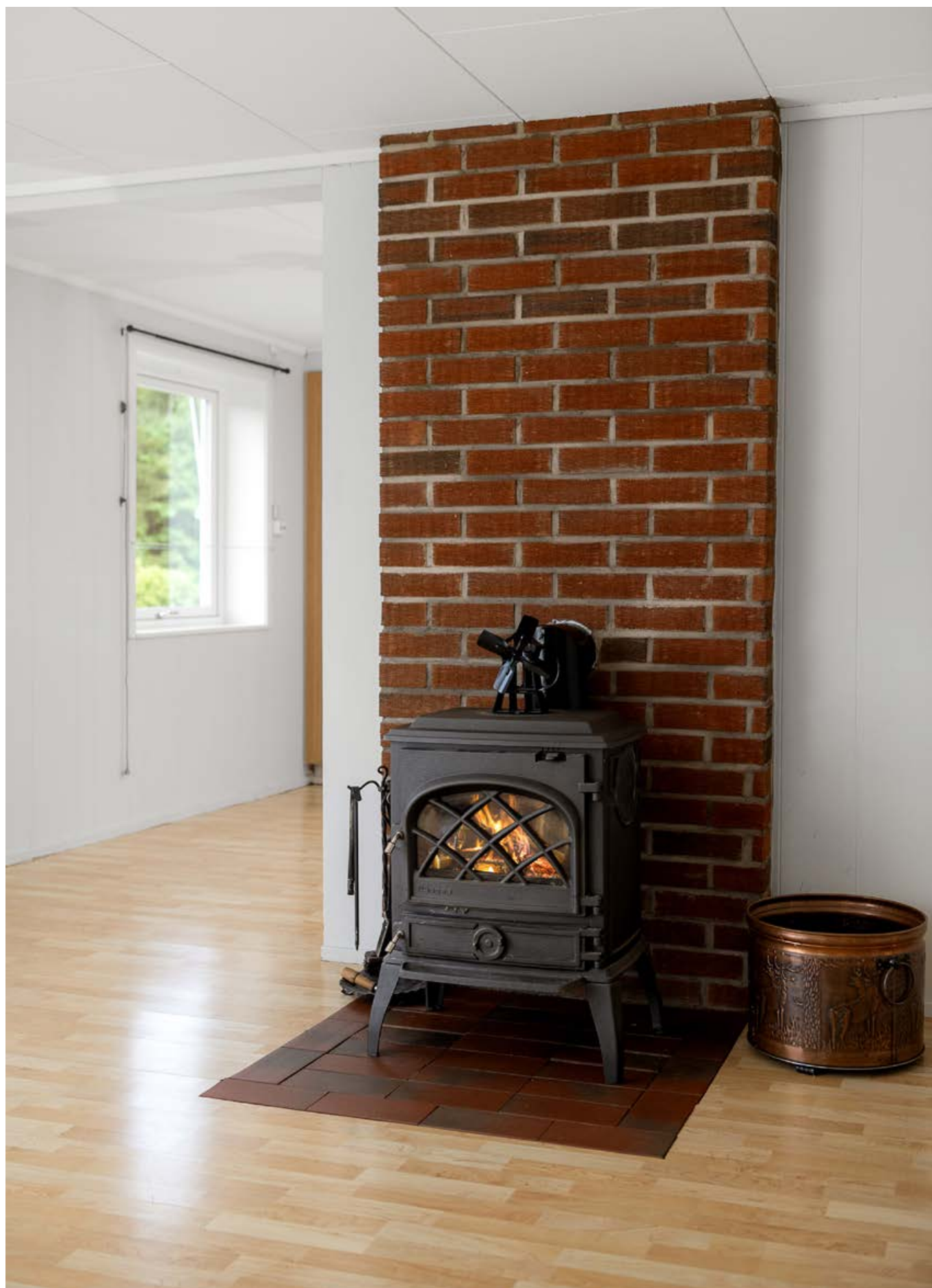
En klassisk vedovn ved en pusset mursteinspipe gir supplerende varme.
