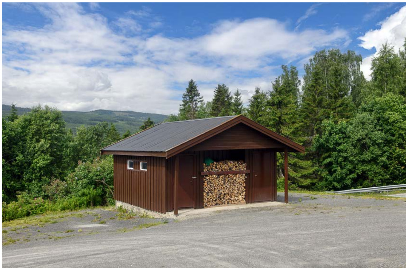
Frittstående uthus fra 1993 på 23 m 2 gir rikelig med lagringsplass.
