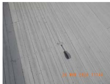
Råteskadet gulvbord
