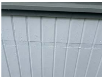
Ufagmessig skjøting av panel
