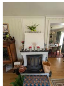
Elementpeis ved søndre pipeløp i stue
