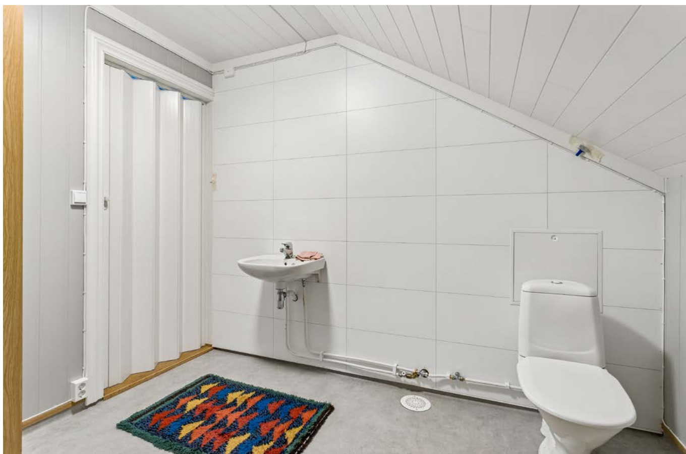
Nylig etablert bad i andre etasje med vegghengt servant og klargjort for dusjkabinett.
