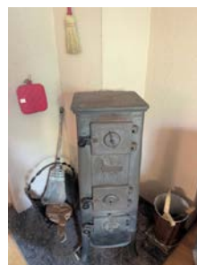
Vedovn ved nordre pipeløp på kjøkken
