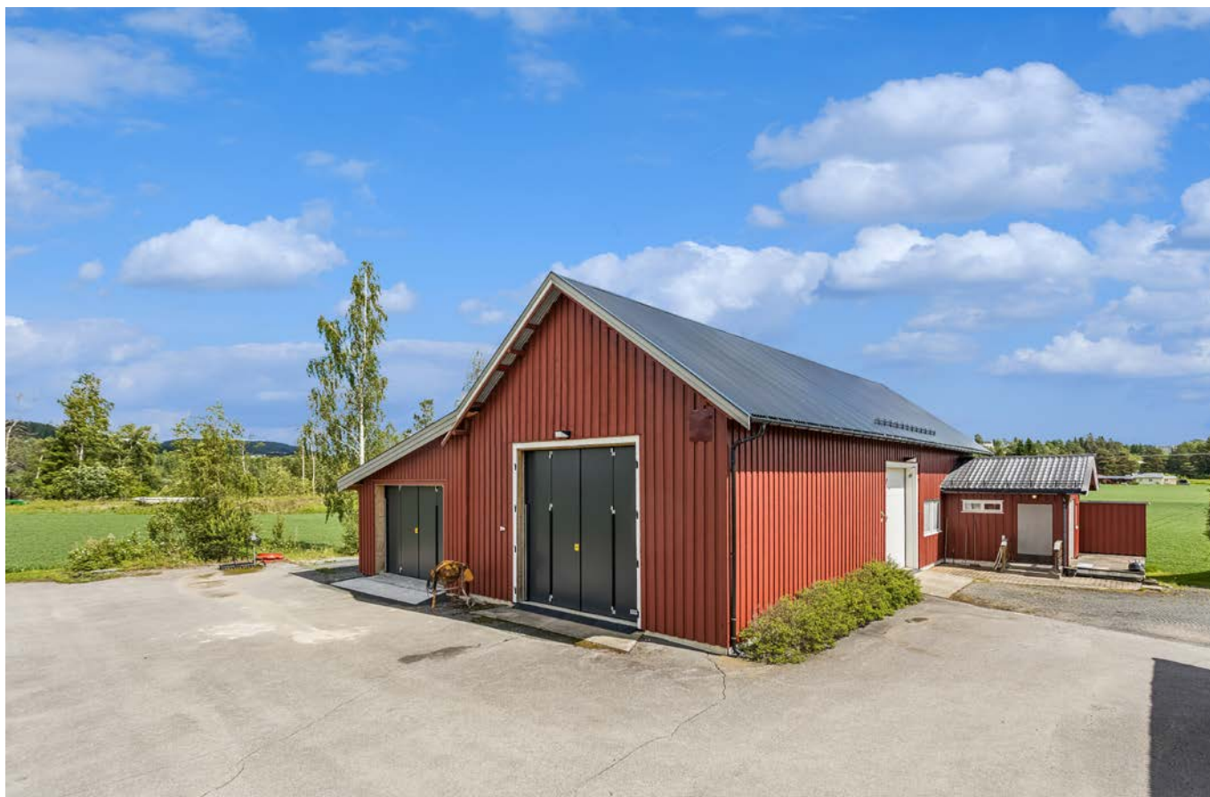
Driftsbygningen fikk nytt tak i 2024 og nye porter i 2022.
