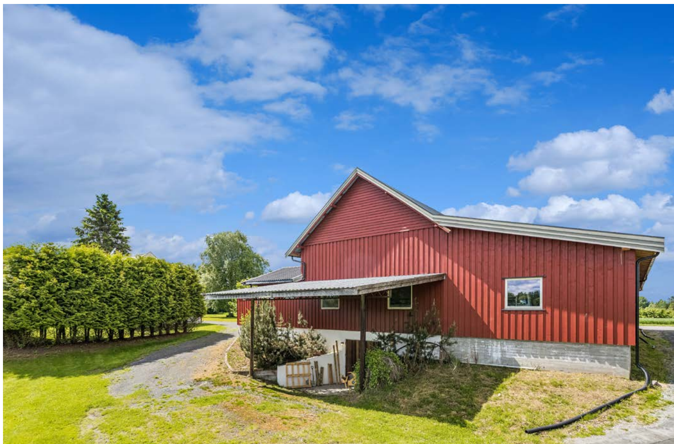
Kjelleren i låven huser teknisk rom og en stor vedbod.
