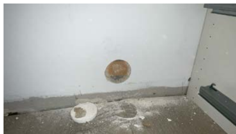
Synlig svill ved hulltaking
