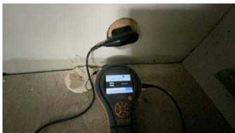
Fuktmåling i svill
