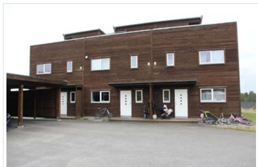
Carport til venstre.
