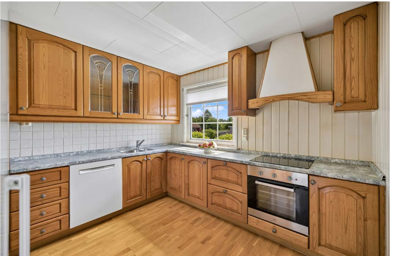
Ventilator med mekanisk avtrekk ført ut av vegg.
