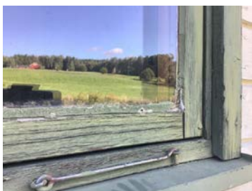
Eksempel på værslitt vindu.
