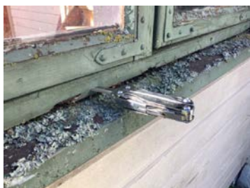
Eksempel på værslitt vindu.
