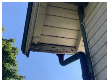
Råteskadet forkantbord.
