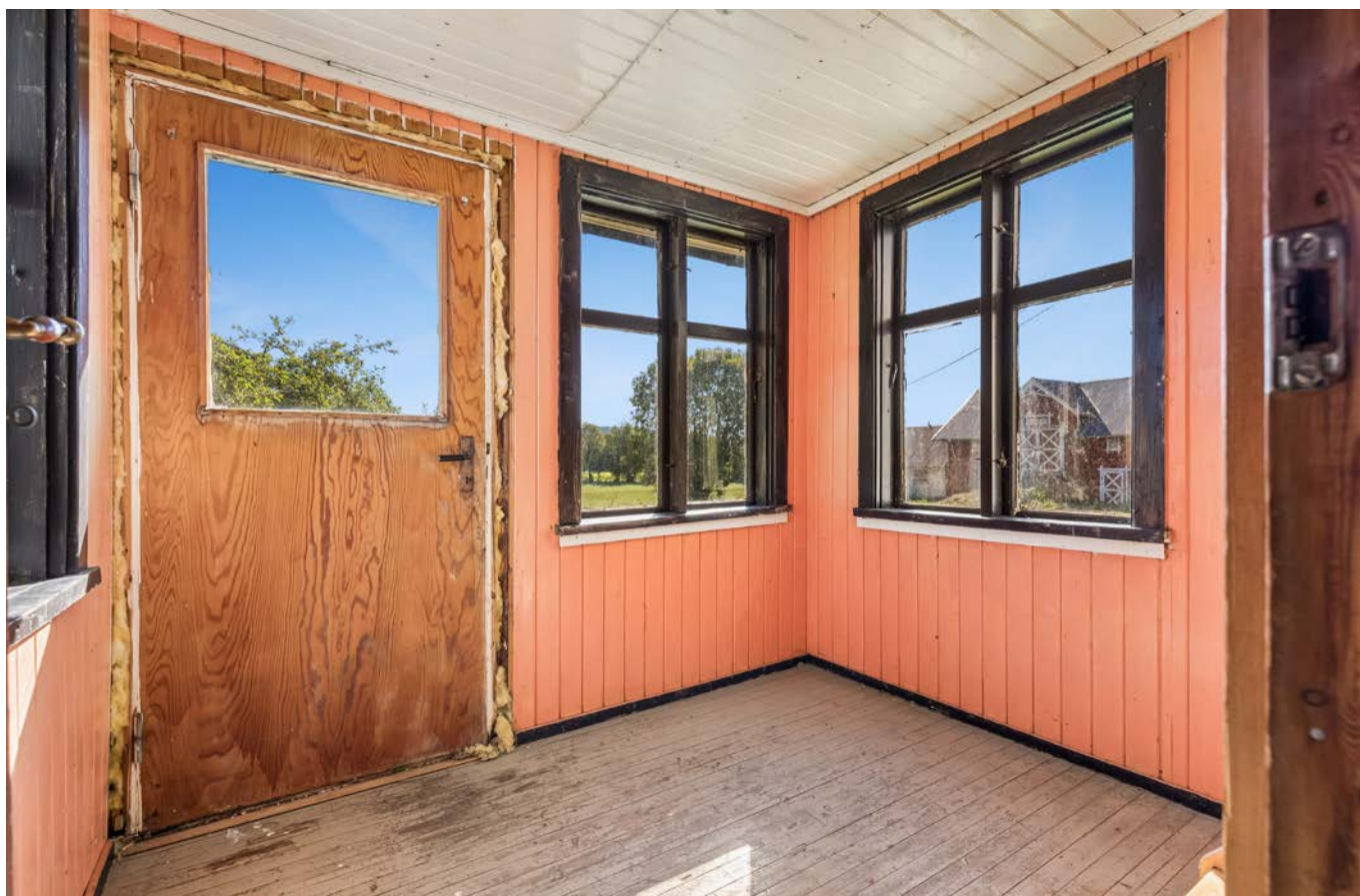
Dette inngangspartiet framstår i dag som en glassveranda med stort potensial!
