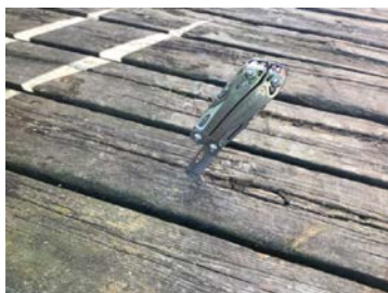
Råteskadet terrassegulv.
