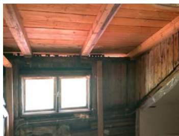
Åpne konstruksjoner i gang i andre etasje.
