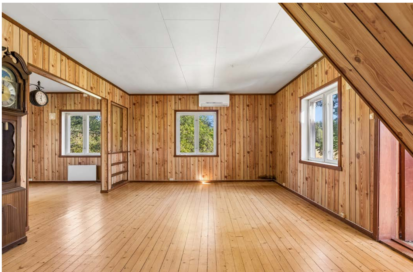
En luft-til-luft-varmepumpe er installert i stuen for effektiv oppvarming.
