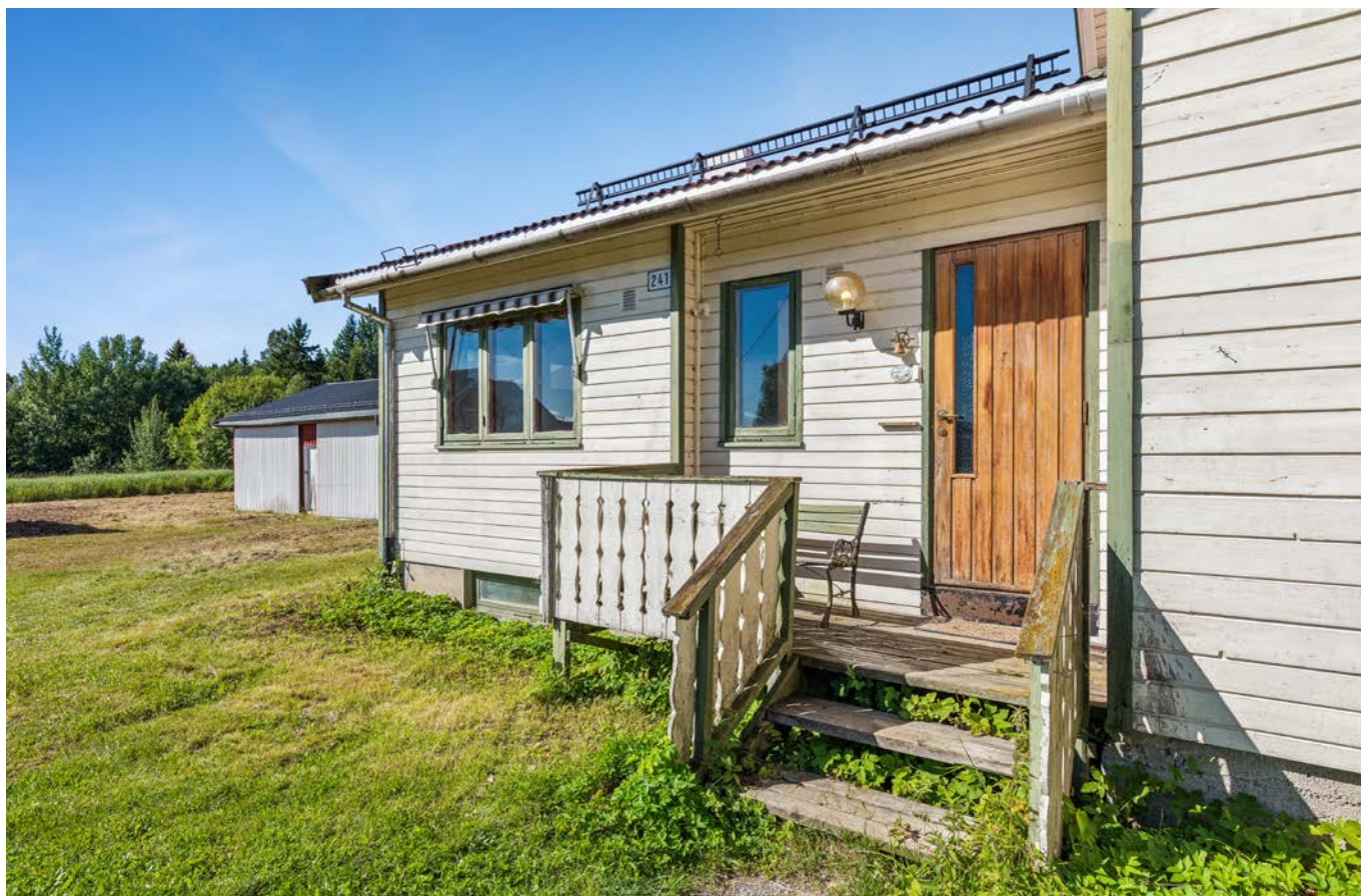
Inngangspartiet er en del av tilbygget og har en østvendt treterrasse.
