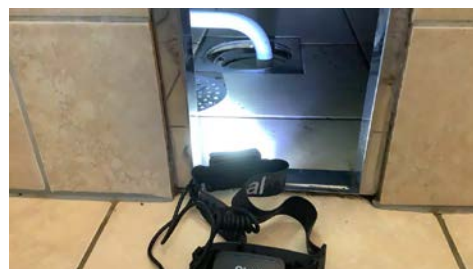
Badegulvet er flatt til motfall. Det er fall i dusjonen. Oppkant mot sluk vil hindre evt lekkasjevann å renne til sluk.
