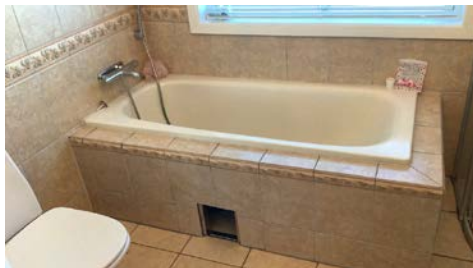
Innmuret badekar, vindu i våtsone
