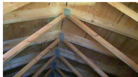
Takstoler og undertak av tre.
