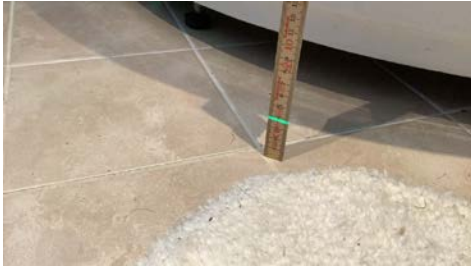
Det er flatt til motfall til området under kabinett.
