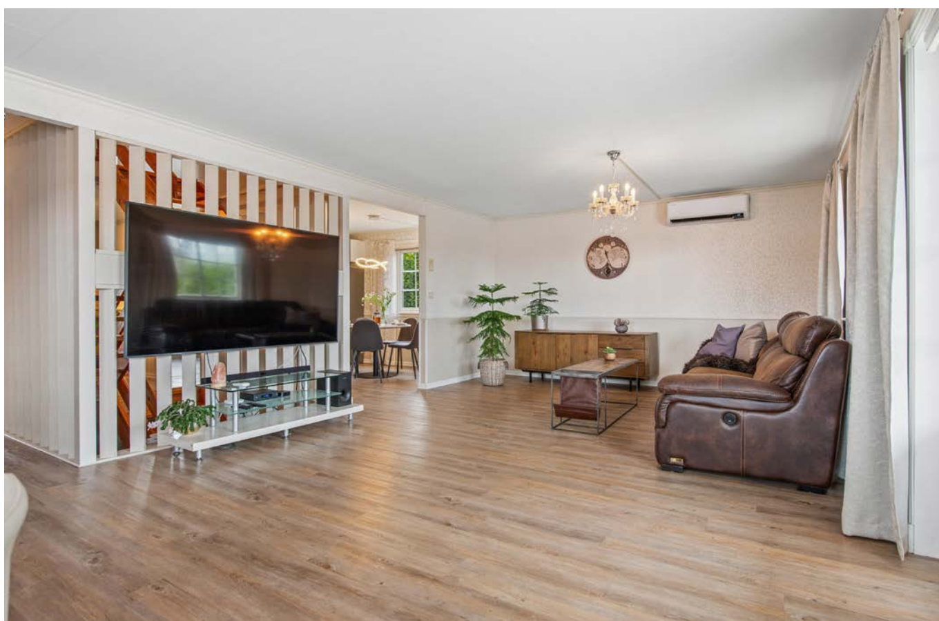
En luft-til-luft varmepumpe fra 2022 sørger for effektiv oppvarming i stuen. I tillegg er det gulvvarme i rommet.
