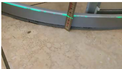
Badegulvet er flatt til motfall. Det er fall i dusjonen. Oppkant mot sluk vil hindre evt lekkasjevann å renne til sluk.
