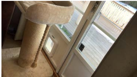
Det er etablert katteluke i balkongdør.
