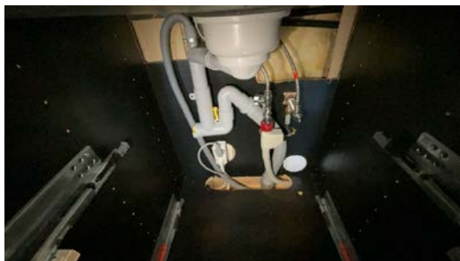
Synlige rør under kjøkkenbenken.
