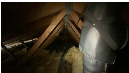
Adkomst til kaldtloft via luke i knevegg.
