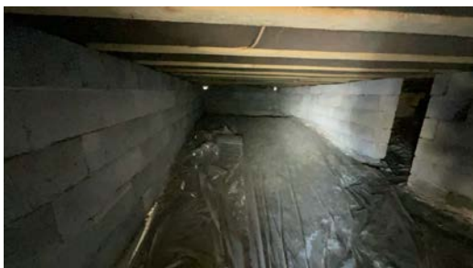
Adkomst til krypkjeller via luke i grunnmuren.
