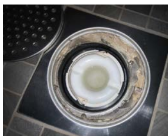
Sluk under slukrist i dusjsone.
