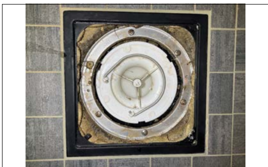
Kontroll av sluk
