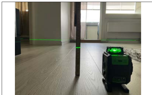
Nivellering og kontroll av fall på gulv på bad.
