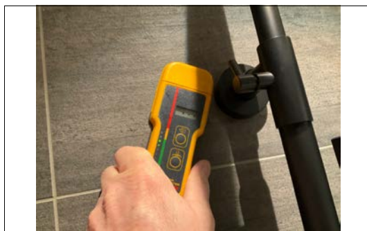
Kontrollspøk med fuktmåler i dusjsjonen.
