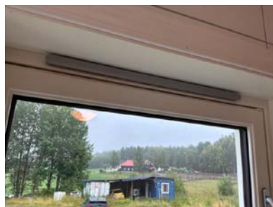
Luftespalte i vindu, for tilluft.
