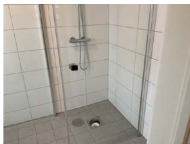
Nytt våtrom. På motsatt side av våtsone er kjøkken på den ene siden og soverom på den andre siden.
