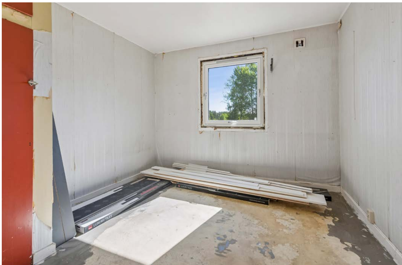
Soverom i hovedetasjen med eldre overflater. Materialer til nytt gulv medfølger.
