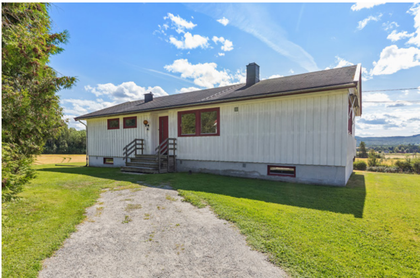
Våningshuset fra 1980 har fasader kledd med trekledning.
