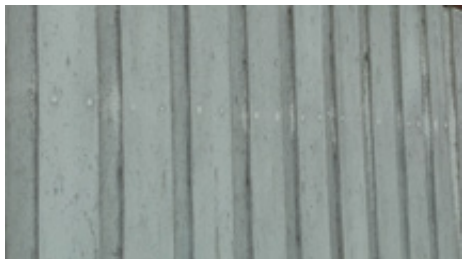
Eksempel på misfarging/svertesopp.
