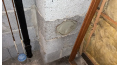
Sotluke i kjeller.
