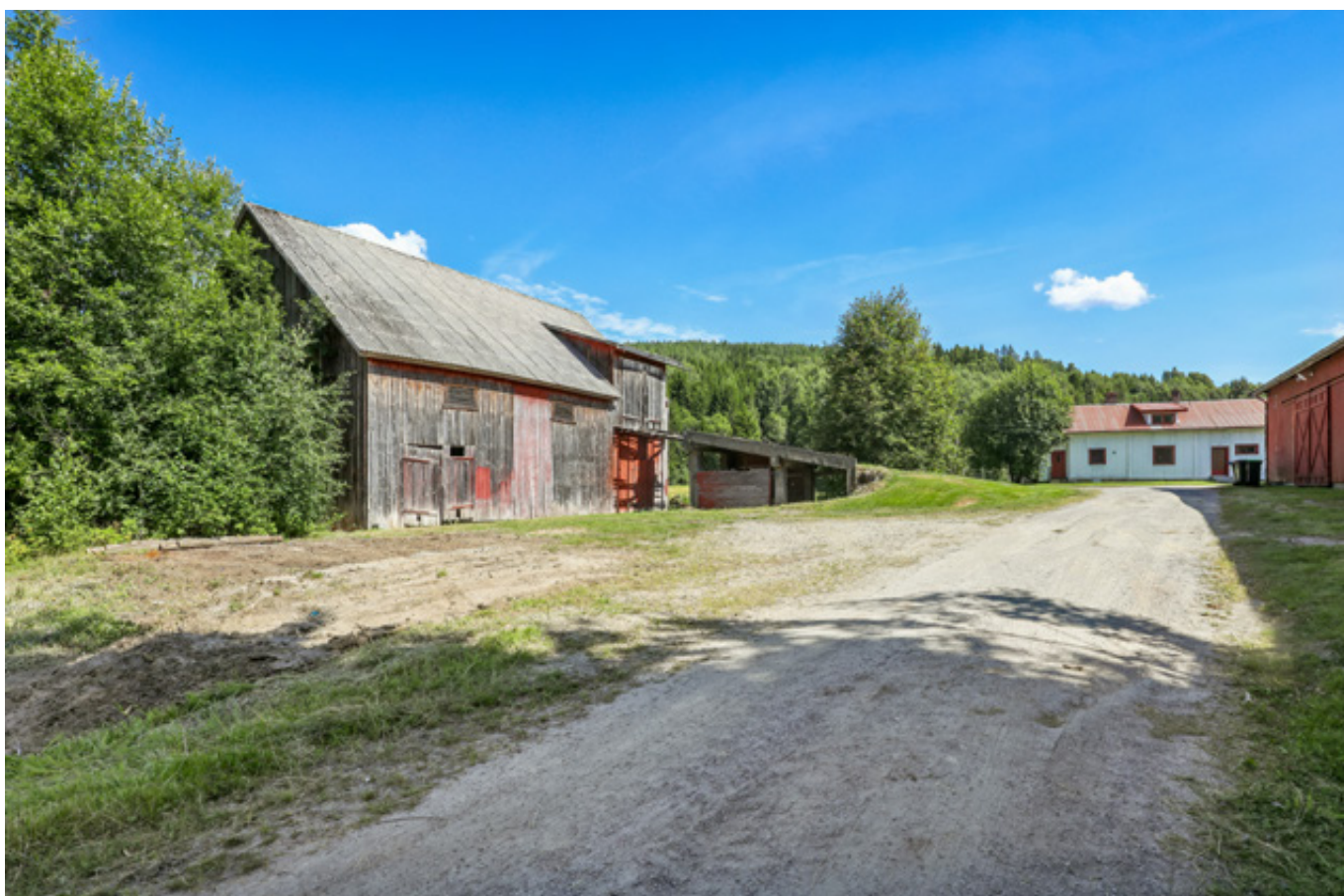
Eldre låvebygning på ca. 163 m 2 fra rundt 1950.
