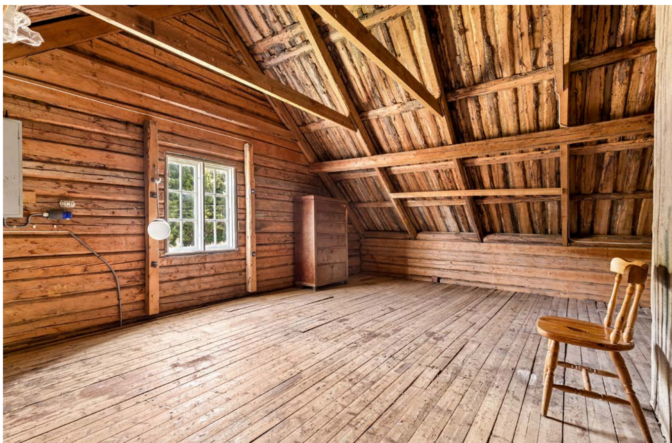
Romslig kaldtloft med synlige bærekonstruksjoner i tre gir rikelig med lagringsplass.
