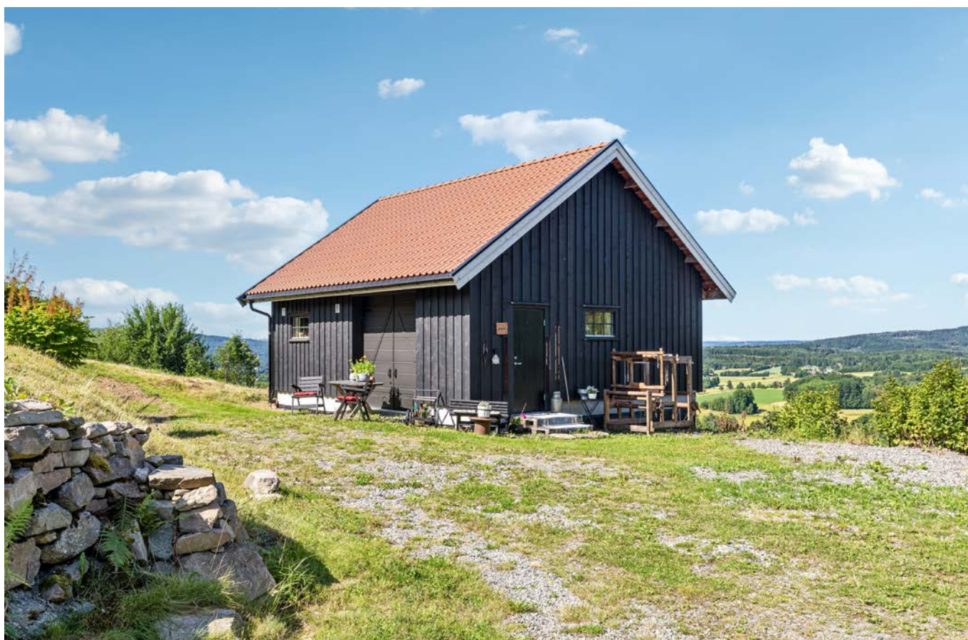
Den frittstående garasjen ble oppført i 2021 og benyttes i dag som systue og verksted.
