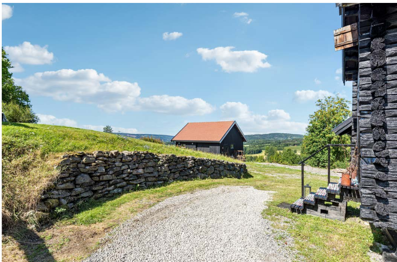
En forstøtningsmur i naturstein rammer inn deler av eiendommen.
