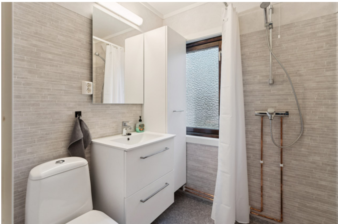
Baderommet ble rehabilitert i 2025 og har elektrisk gulvvarme for økt komfort.
