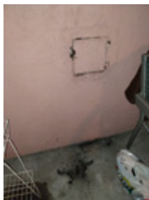
Tilknyttet vedovn i stue 1.etasje, brannsikring mot gulv med metallplate. Toppmontert røykgassrør med feieluke.
