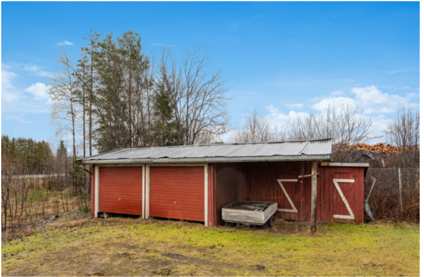
Frittstående dobbelgarasje på 46 m 2 med tilhørende vedskjul og bodplass.
