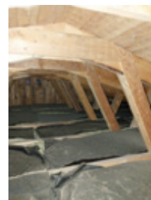
Kaldtloftet i tilbygget, besiktiget via åpning fra opprinnelige kaldtloft.
