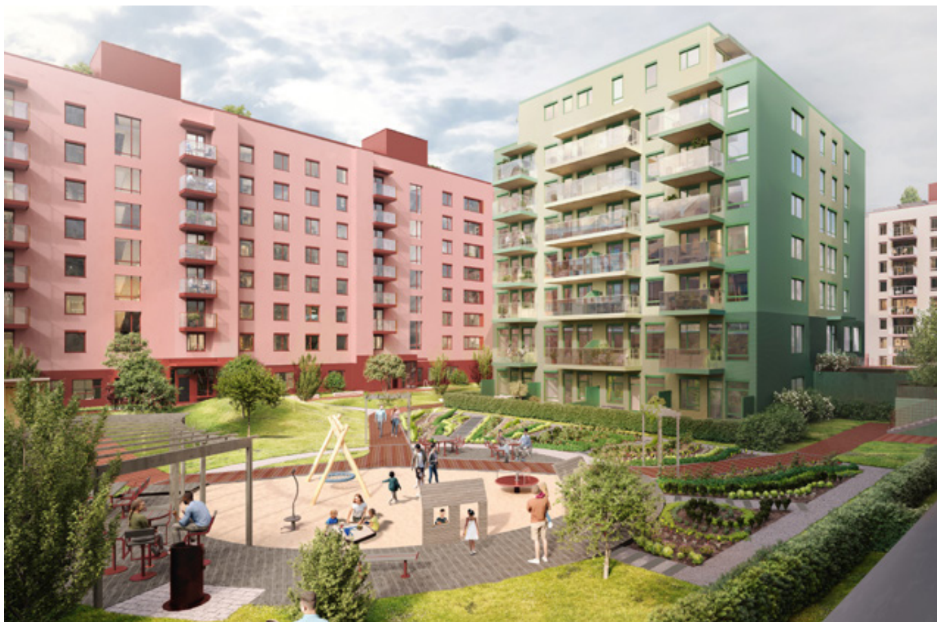
Romslige og pent opparbeide bilfrie gårdsrom
