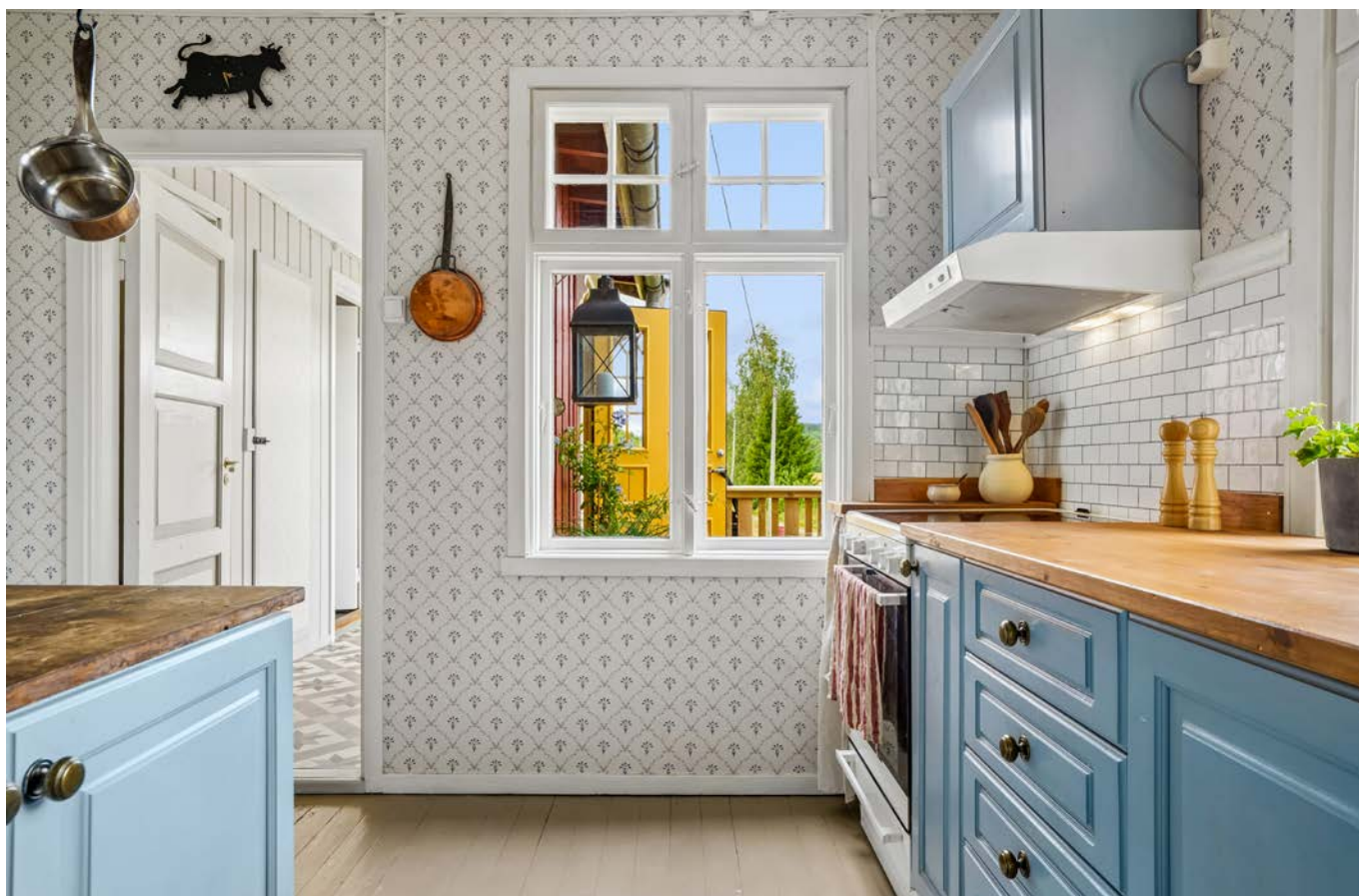
Kjøkkenventilator med avtrekk ut og flisfelt over benken.
