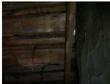
Synlig lyser ut ved pipe
