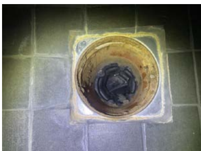
Sluk dypt ned i gulvet/betongen. Tidligere slukrist-ramme synes under dagens slukrist.
