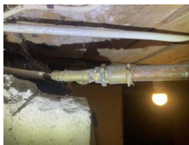
Det var litt kondensering på inntaksledning vann.
