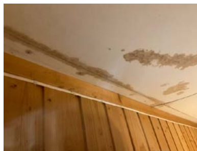
Skjolder i himling trapperom innefor entre mot kjøkken.
