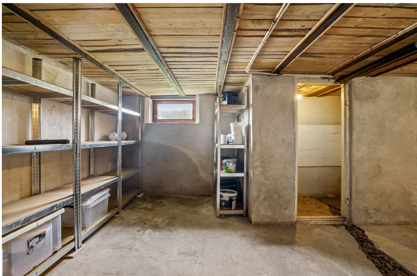
Kjelleren har betonggulv og et gulvareal på ca. 48 m 2 fordelt på fire rom, ideelt for lagring.
