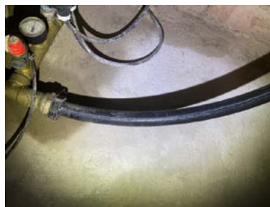
Det var litt kondensering på inntaksledning vann.
