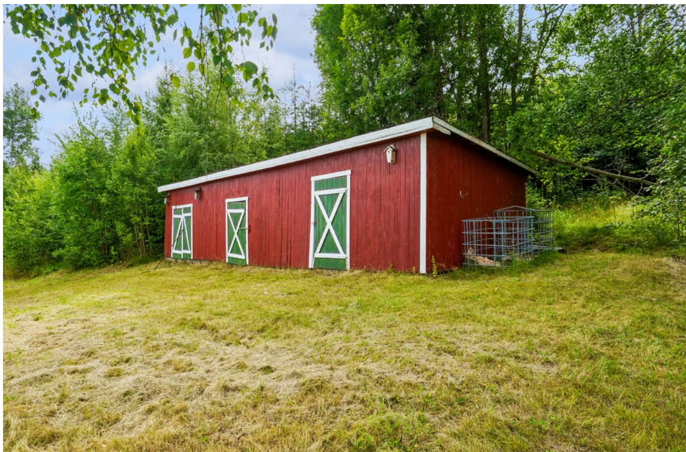
Praktisk uthus på 48 m 2 , inndelt i tre boder for oppbevaring av materialer og ved.
