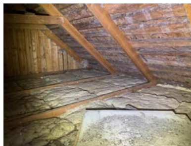
Ingen spesiell ventilering, men undertaket av stikker har en form for "naturlig ventilering"
