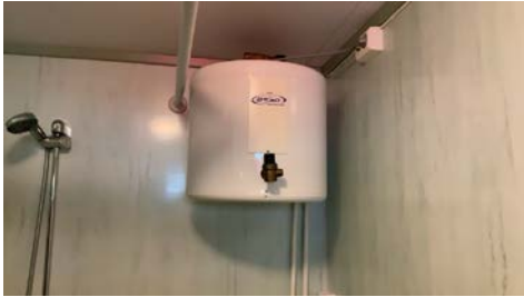
Gammel Vvs bereder på bad.
