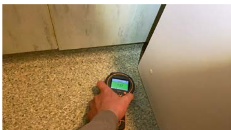
Ved enkle fuktsøk ble det ikke registrert unormale verdier.
