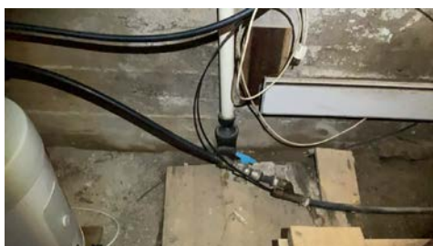
Stake luke i krypkjeller.
