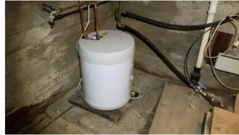
Vvs bereder fra 2024 i kryp kjeller.
