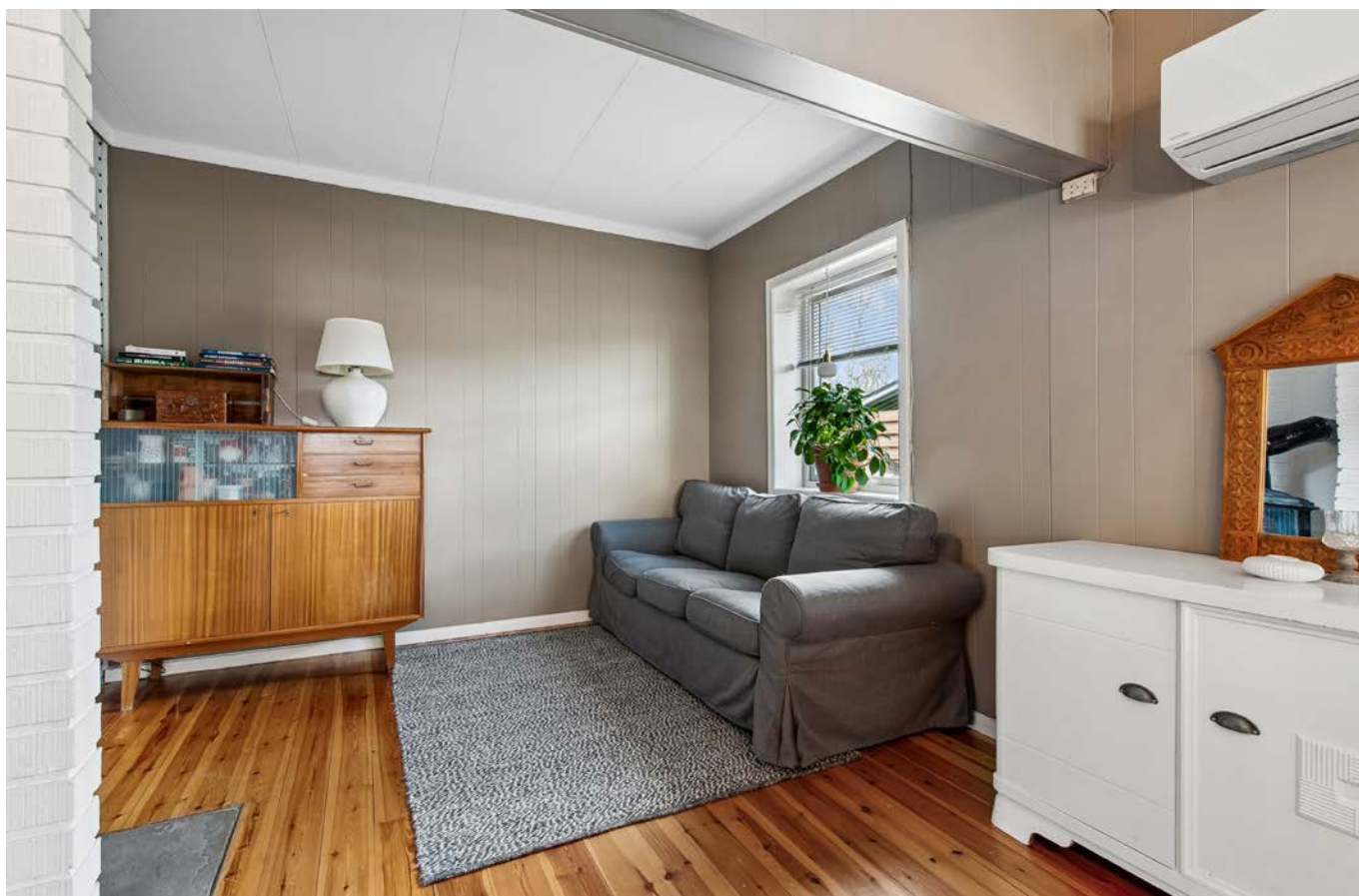
En luft-til-luft varmepumpe, installert i 2015, supplerer oppvarmingen i denne delen av huset.
