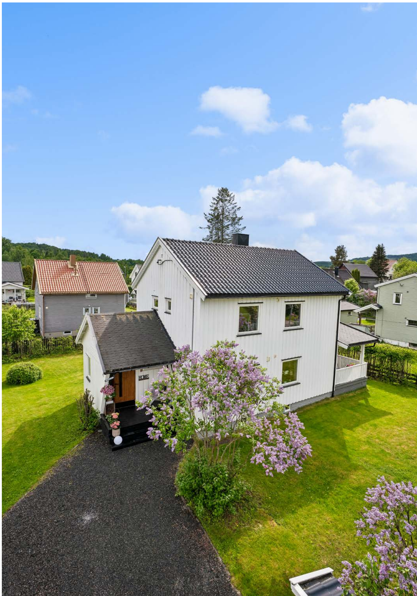
Enebolig med utvendig kledning, vindtetting og de fleste vinduer skiftet i 2014.
