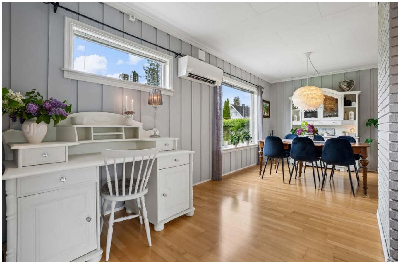
Effektiv oppvarming med en luft-til-luft-varmepumpe installert i 2016.
