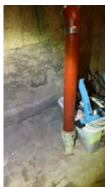
Nederste del av støpejernsrør i kjeller er som fra byggeåret.
