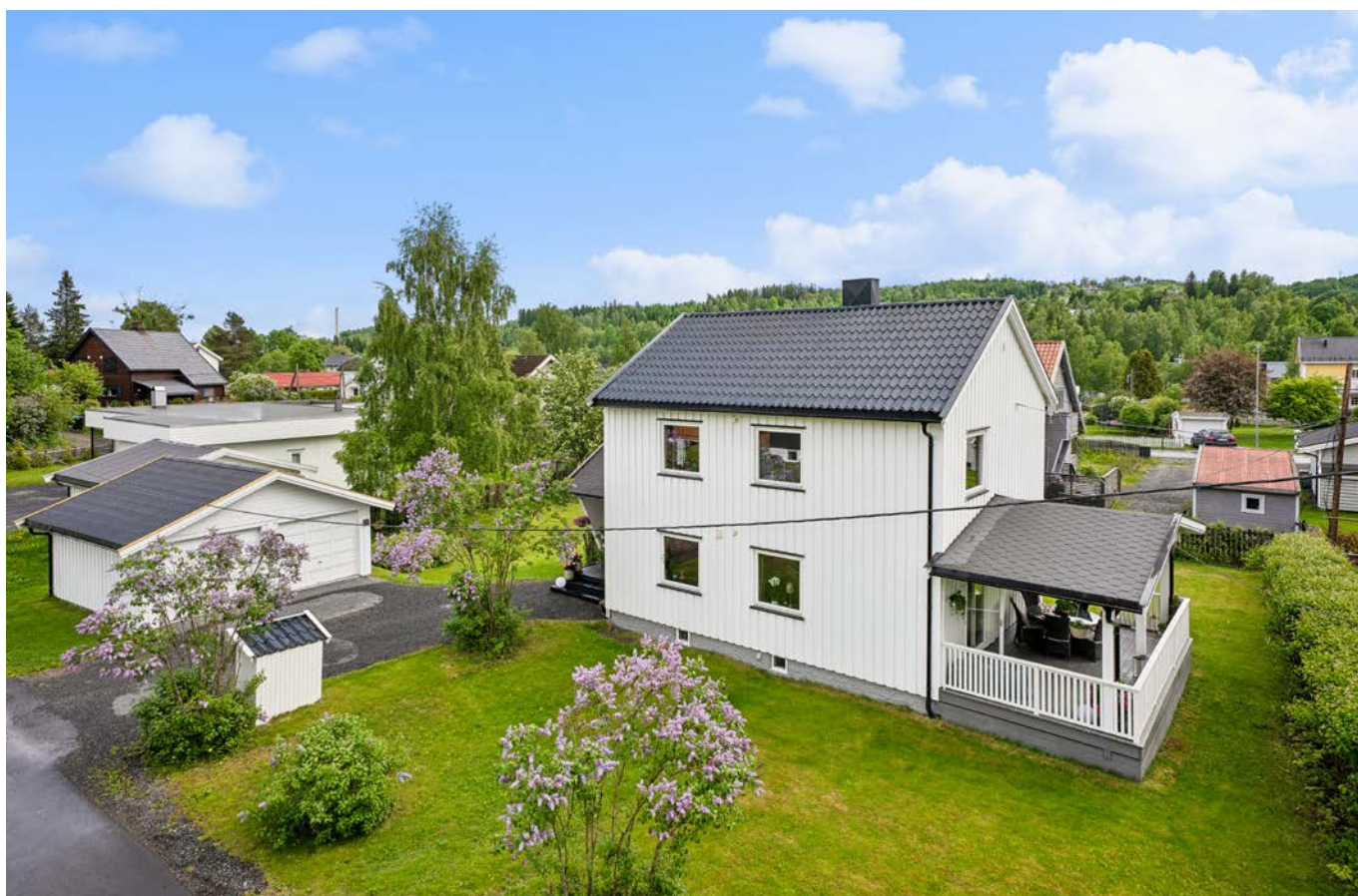
Eiendommen er teknisk oppgradert med nye utvendige vann- og avløpsrør i 2023.
