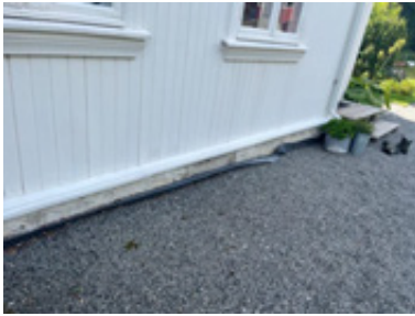
Synlig fuksikring mot mur på tilpasses.
