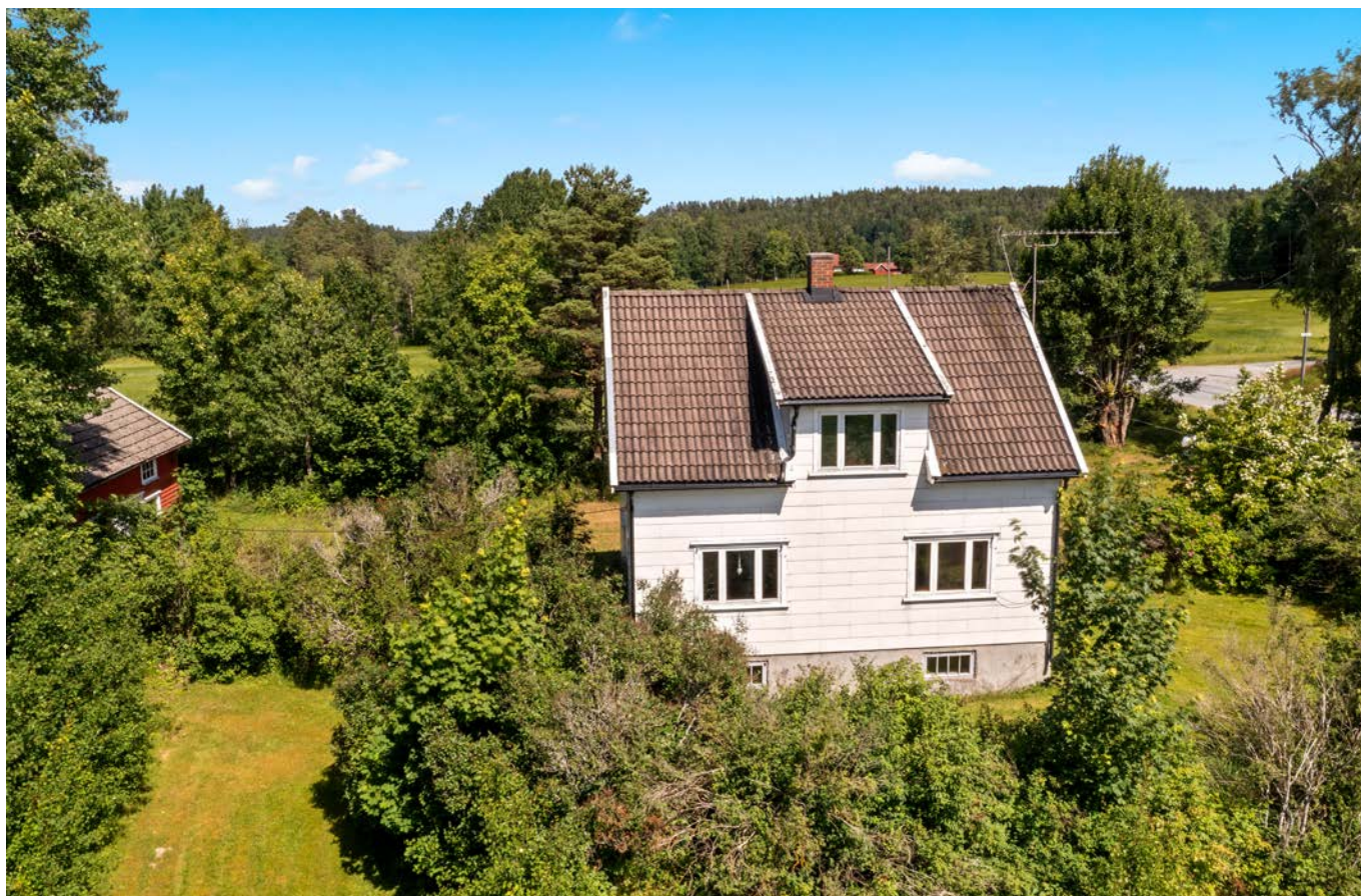
Taket er tekket med betongtakstein.
