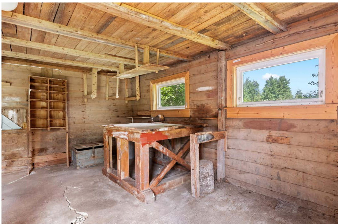
Første etasje i uthuset, ideelt for verksted eller lagring.
