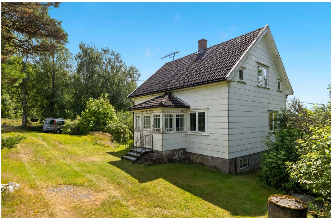
Dette er en eldre enebolig, antatt oppført i 1938. Boligen har hovedsakelig en eldre standard, dels fra byggeåret, og er å anse som et renoveringsobjekt. Her kan du forme ditt eget hjem, etter egne ønsker.
