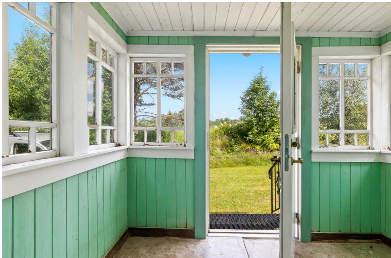
Overbygget inngangsparti med vinduer på tre sider.
