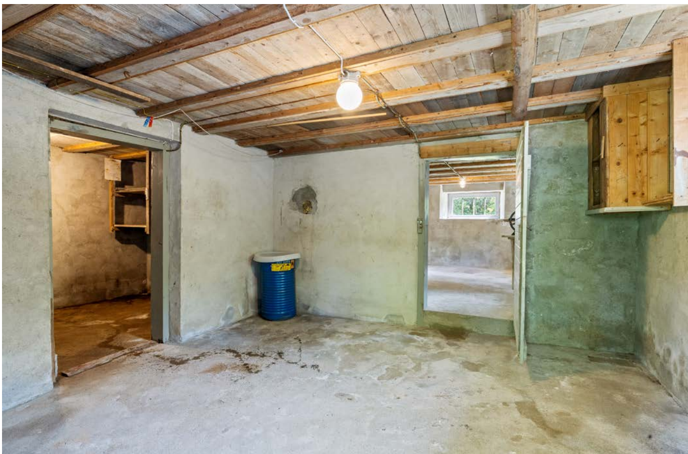
Kjeller/Krypkjeller med betonggulv og flere uinnredede rom for lagring.
