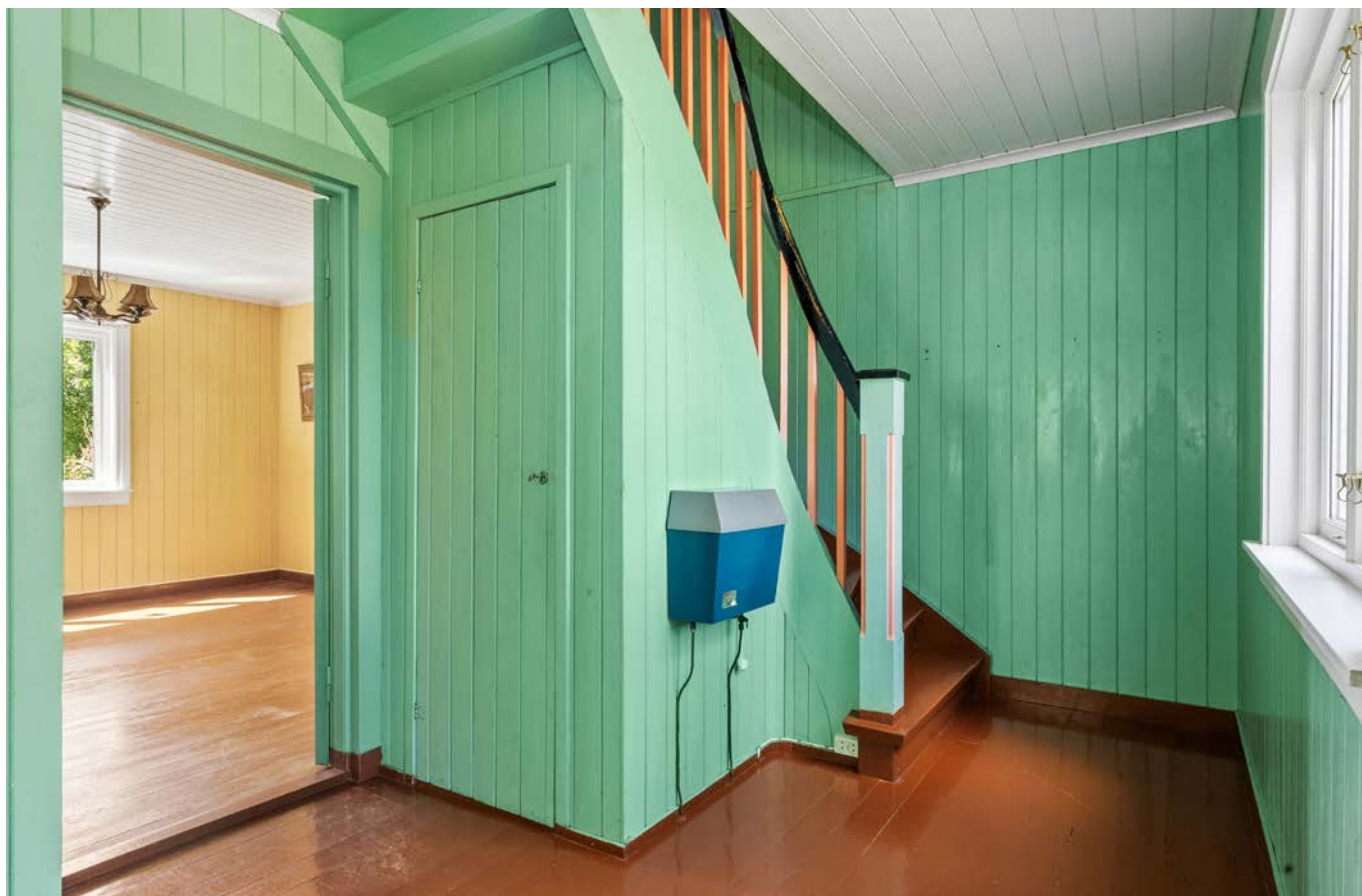
Entré i første etasje med malt trepanel og trapp til andre etasje. Gammel dagtank for parafinfyring, skal etter dagens regelverk kobles ut og fjernes, etter gjeldene regler.
