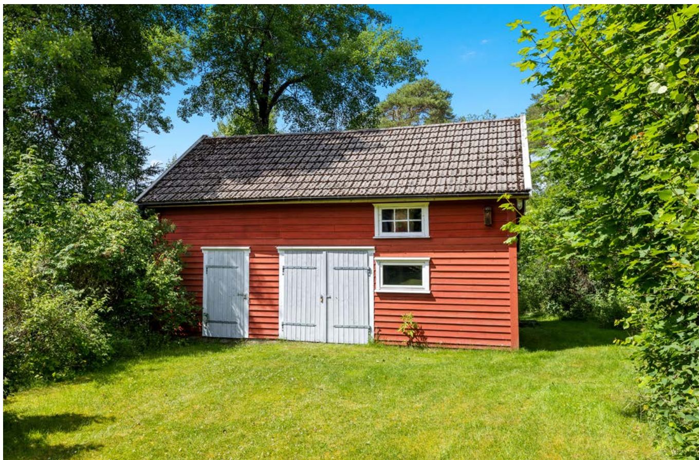
Separat uthus/garasje med stående trekledning og takstein på taket. Innvendig er det to boder og en hems.
