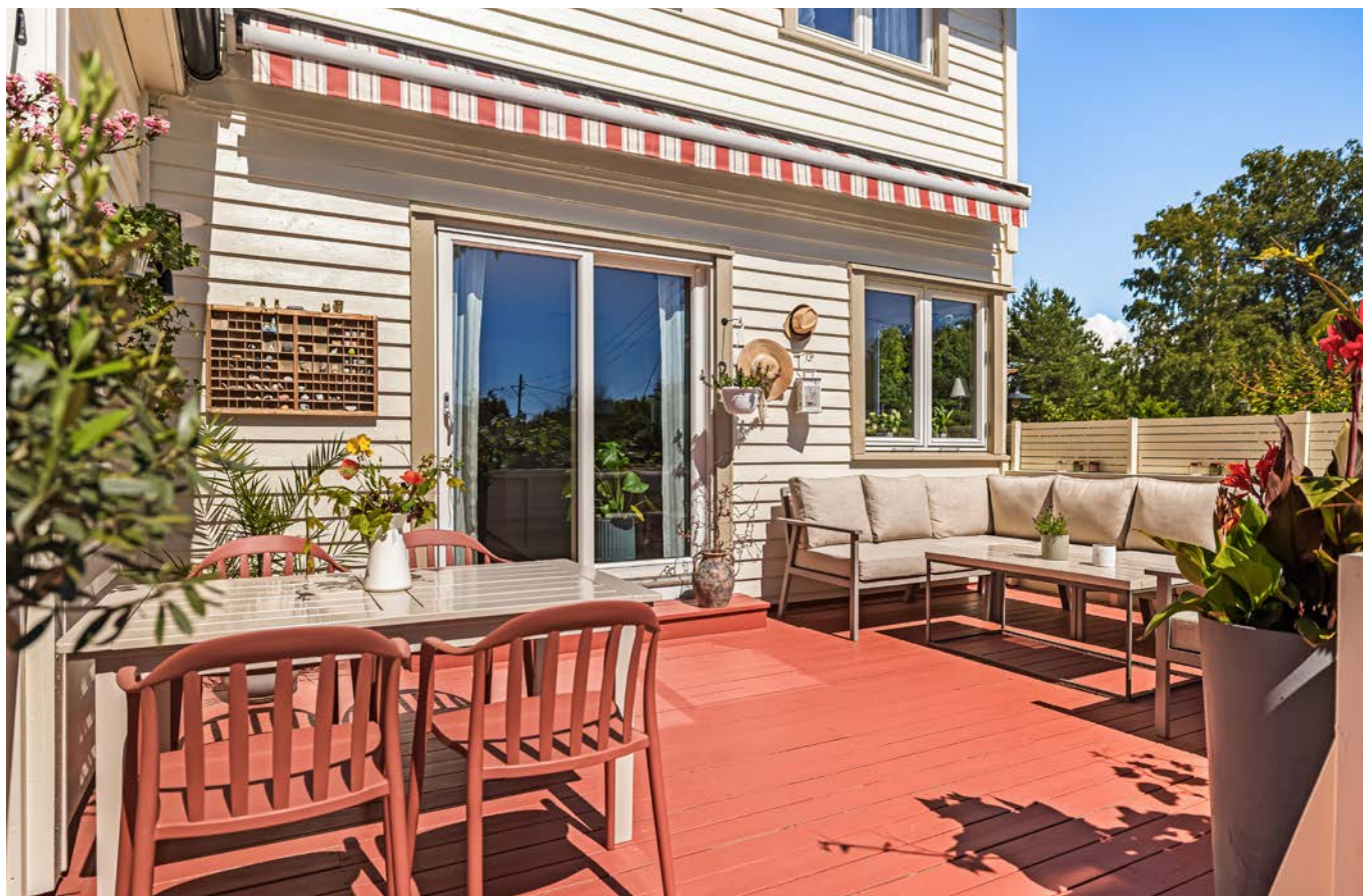
Skyvedøren i malt tre med 2-lags glass fra 2017 fra kjøkkenet ut til terrassen.
