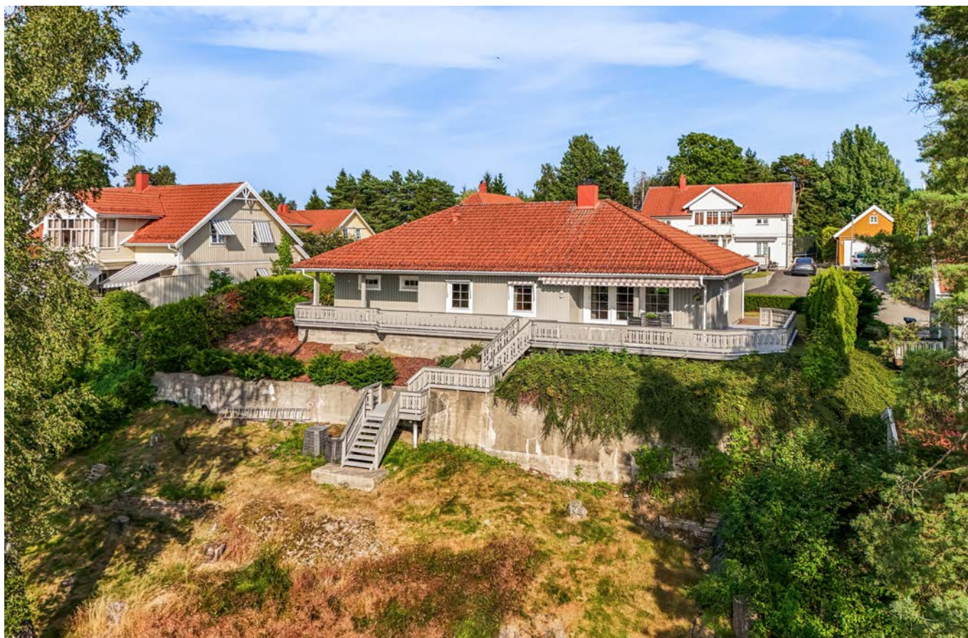
Eneboligen er fundamentert med støpt plate og har grunnmur i isolerte elementer.
