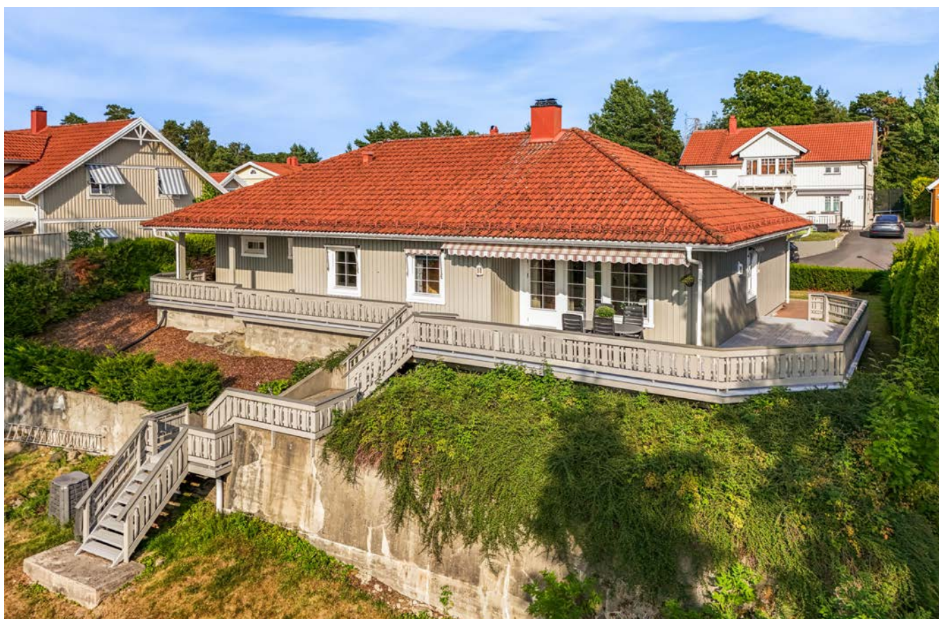
Yttervegger med stående bordkledning og tak tekket med betongtakstein.
