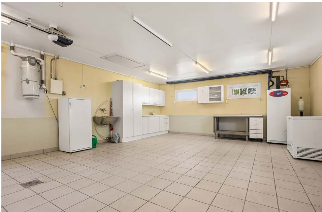
Stor, integrert garasje med flislagt gulv, sentralstøvsuger og tekniske installasjoner.
