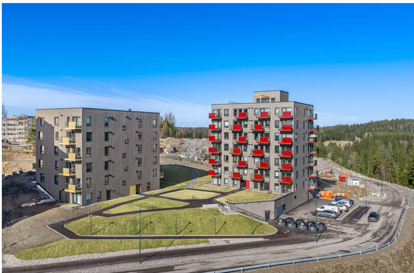
Boligsameiet Solerunden 64-66 består av 2 bygg med til sammen 72 leiligheter.
