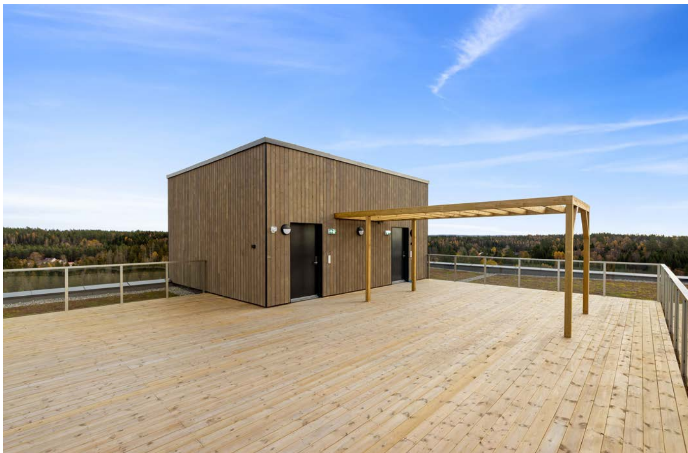
Felles takterrasse i Solerunden 66 for alle beboere.
