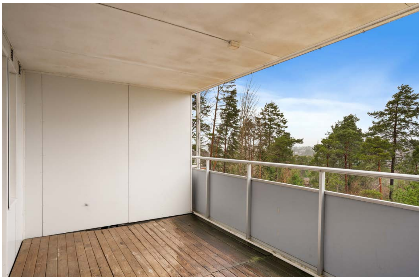
Terrassen er en fin forlengelse av stuen og har rekkverk i stål og plater.
