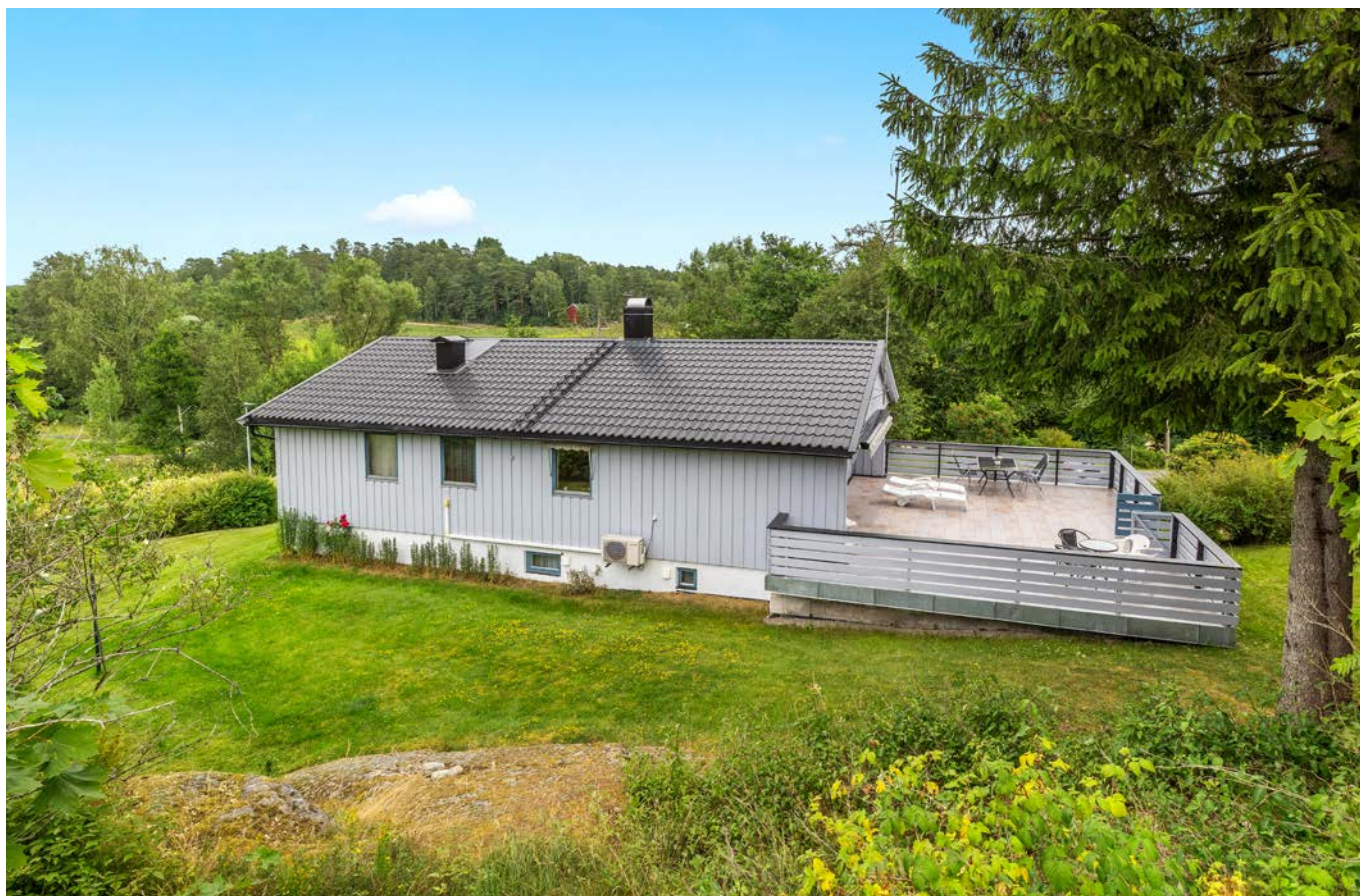
Taket er tekket med takplater i metall, lagt i 2016.
