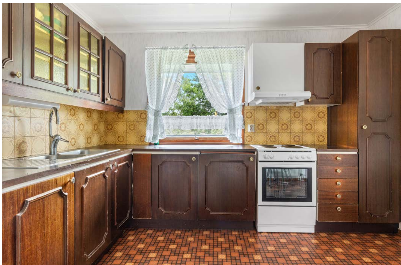
Kjøkkeninnredning med laminatbenkeplate og ventilator med avtrekk ut.
