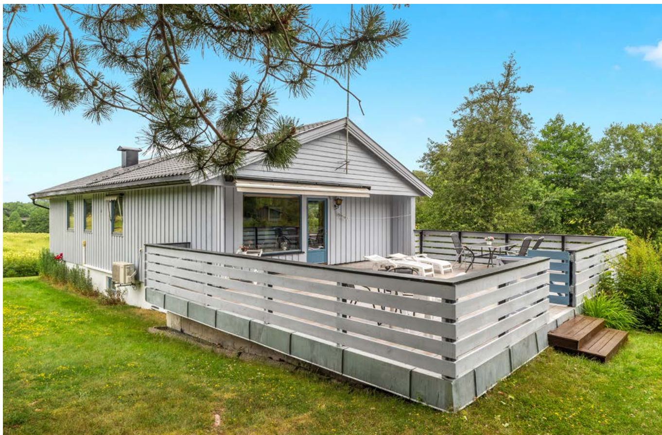
Enebolig fra 1978 med yttervegger i bindingsverkskonstruksjon.
