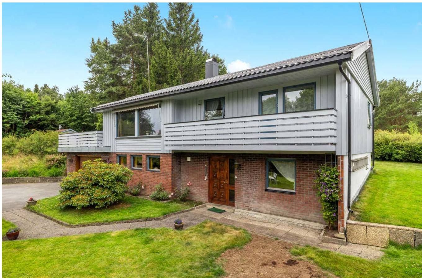
Utvendige oppgraderinger inkluderer ny kledning på sydveggen fra 2024 samt utskifting av flere vinduer
