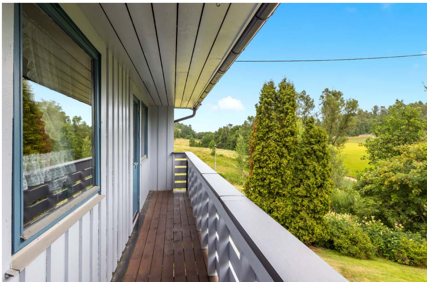
Balkongen er utført i trekonstruksjon.
