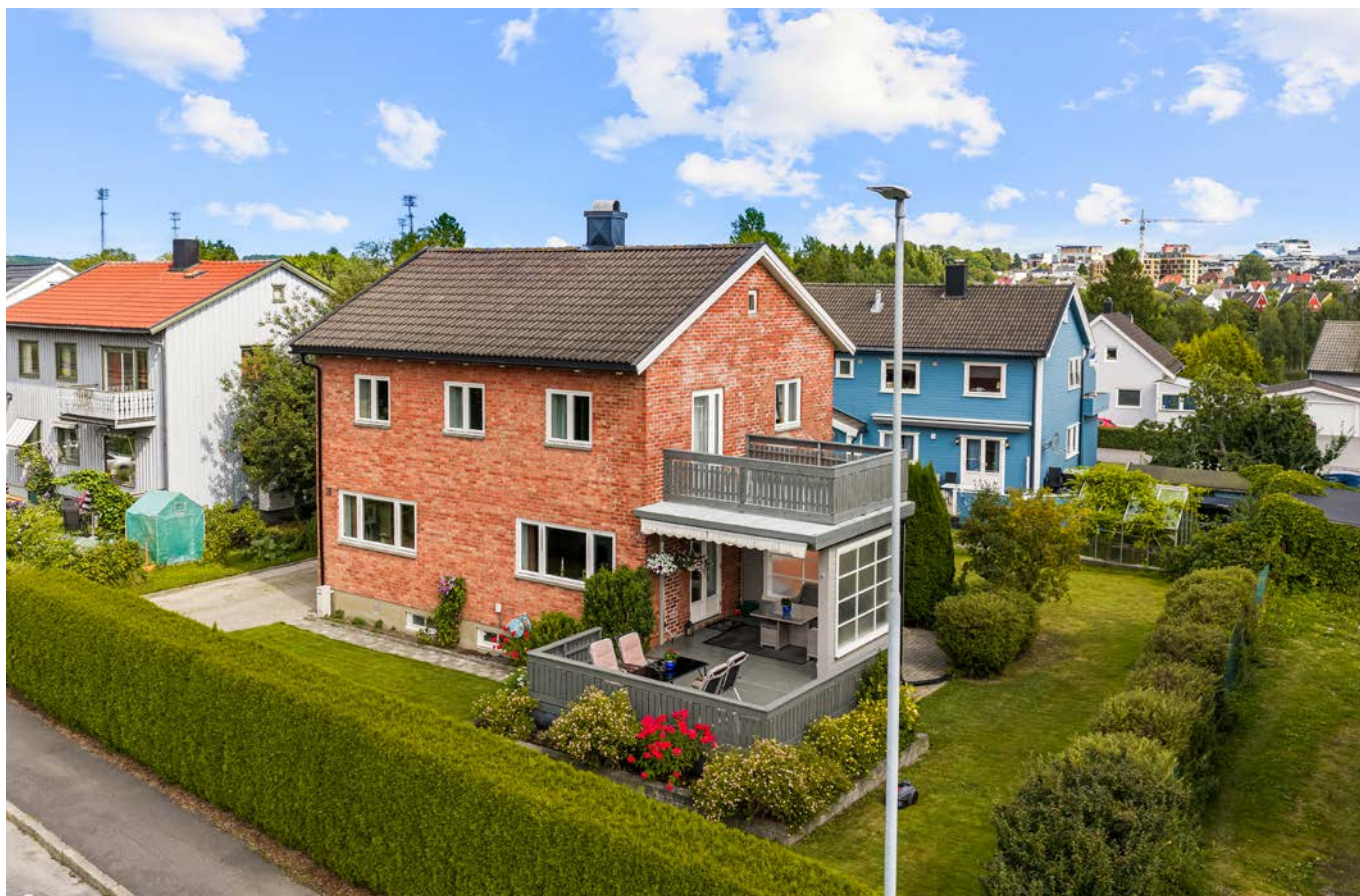
Yttertaket ble lagt om med ny betongtakstein i 2001.
