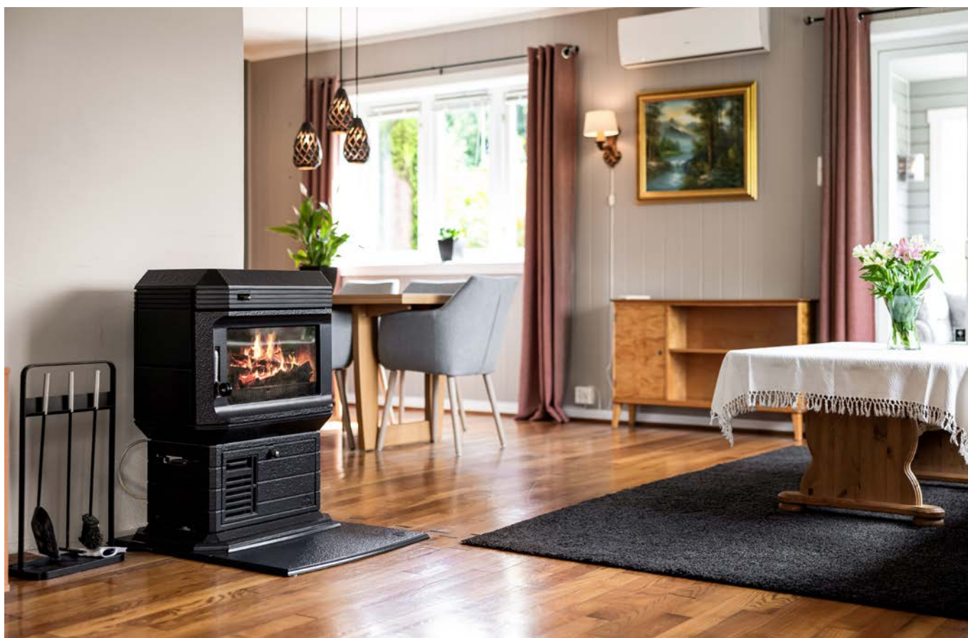
Peisovn fra 2003 og luft-til-luft varmepumpe fra 2014 sørger for effektiv oppvarming.
