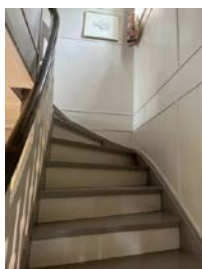
Innvendig trapp til andre etasje.
