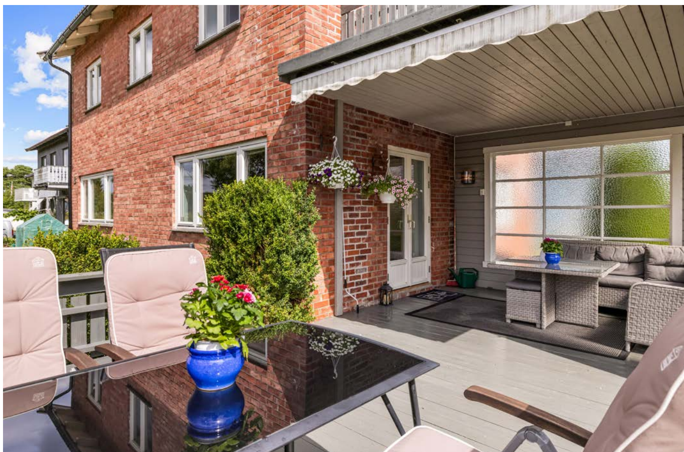
Uteplassen er oppført i impregnerte trematerialer på støpte fundamenter.
