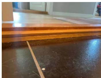
Overgang ved terskel.
