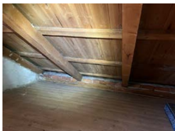
Deler av undertak og loft.
