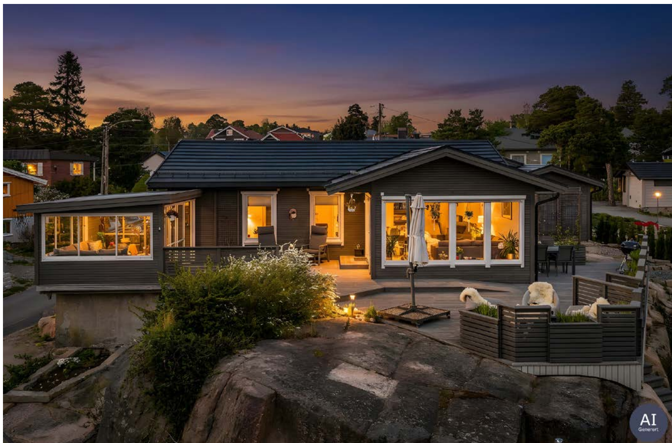
Eneboligen er betydelig modernisert, med nytt tak, etterisolert, ny kledning og nye vinduer installert i perioden 2018-2020.
