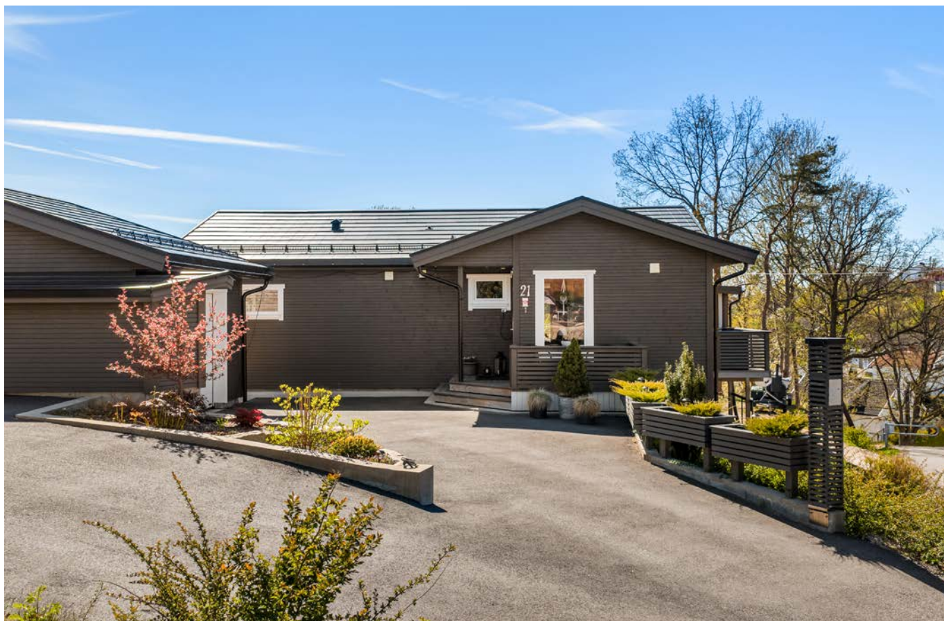
Gårdsplassen er asfaltert og det er staudebed. Koselig liten terrasse ved inngangspartiet.
