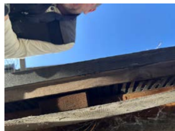
Lufting og musebånd bak kledning
