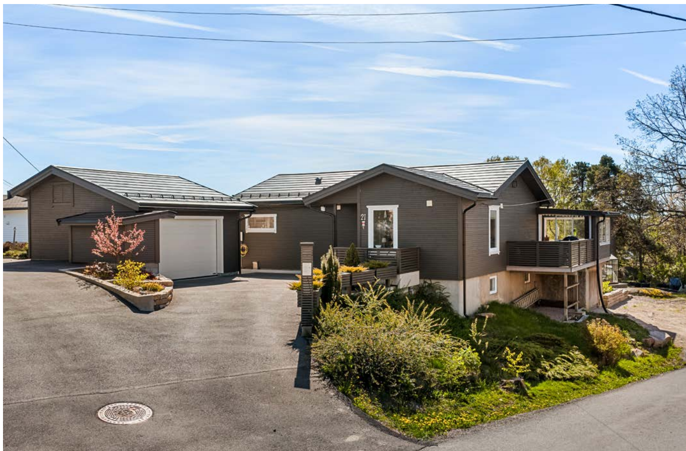
Ny, frittstående garasje på 40 m 2 ble bygget i 2024, og har elektrisk leddport.
