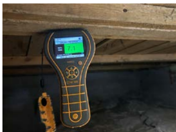
Ingen indikasjon på fukt ved befaring.
