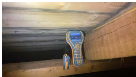
Det ga ikke indikasjon på fukt på befæringsdato
