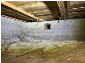
Inspeksjonshull for deler av krypkjeller uten tilgang.
