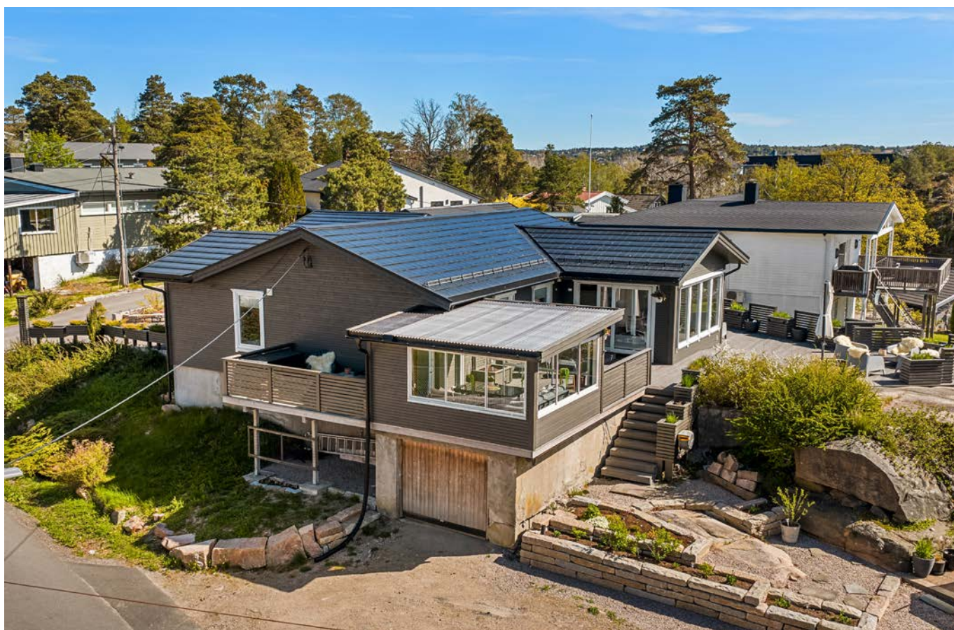
Under hagestuen finnes den opprinnelige garasjen.
