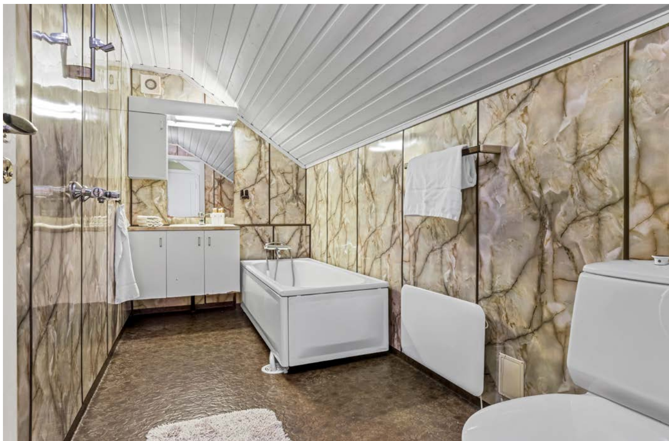
Bad i andre etasje med badekar, vinylbelegg på gulv og baderomsplater på vegg.
