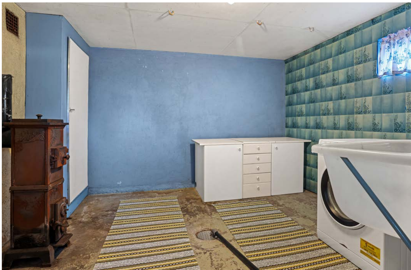
Praktisk vaskerom i kjelleren med opplegg for vaskemaskin og eldre soilsluk.
