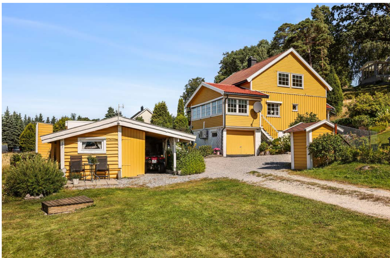
Integrert garasje i kjelleren og et separat uthus med carport og bod.
