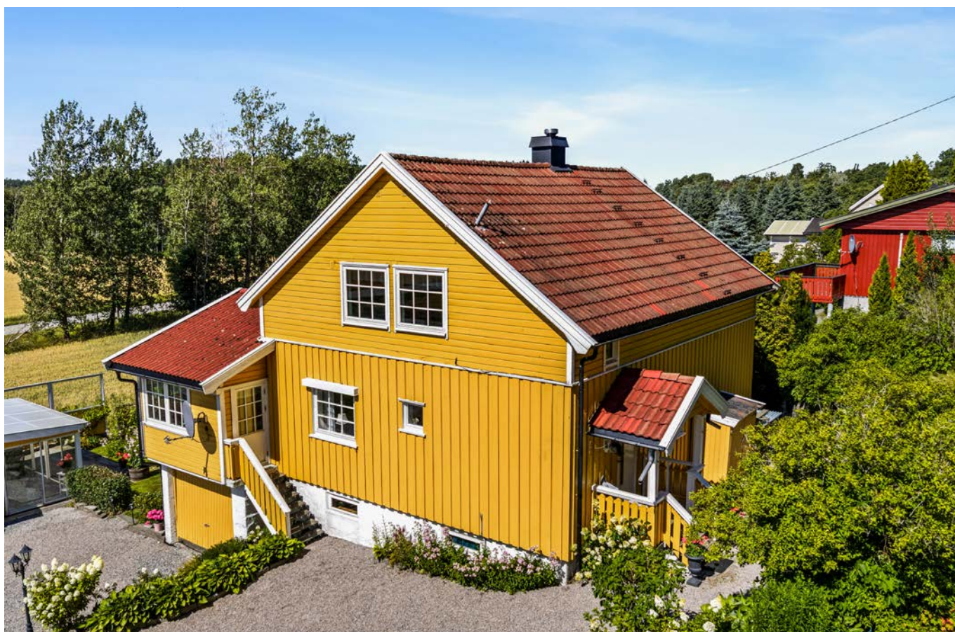
Overbygget inngangsparti med trapp i trekonstruksjon.
