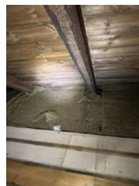
Isolasjon lagt tett ut mot undertak.
