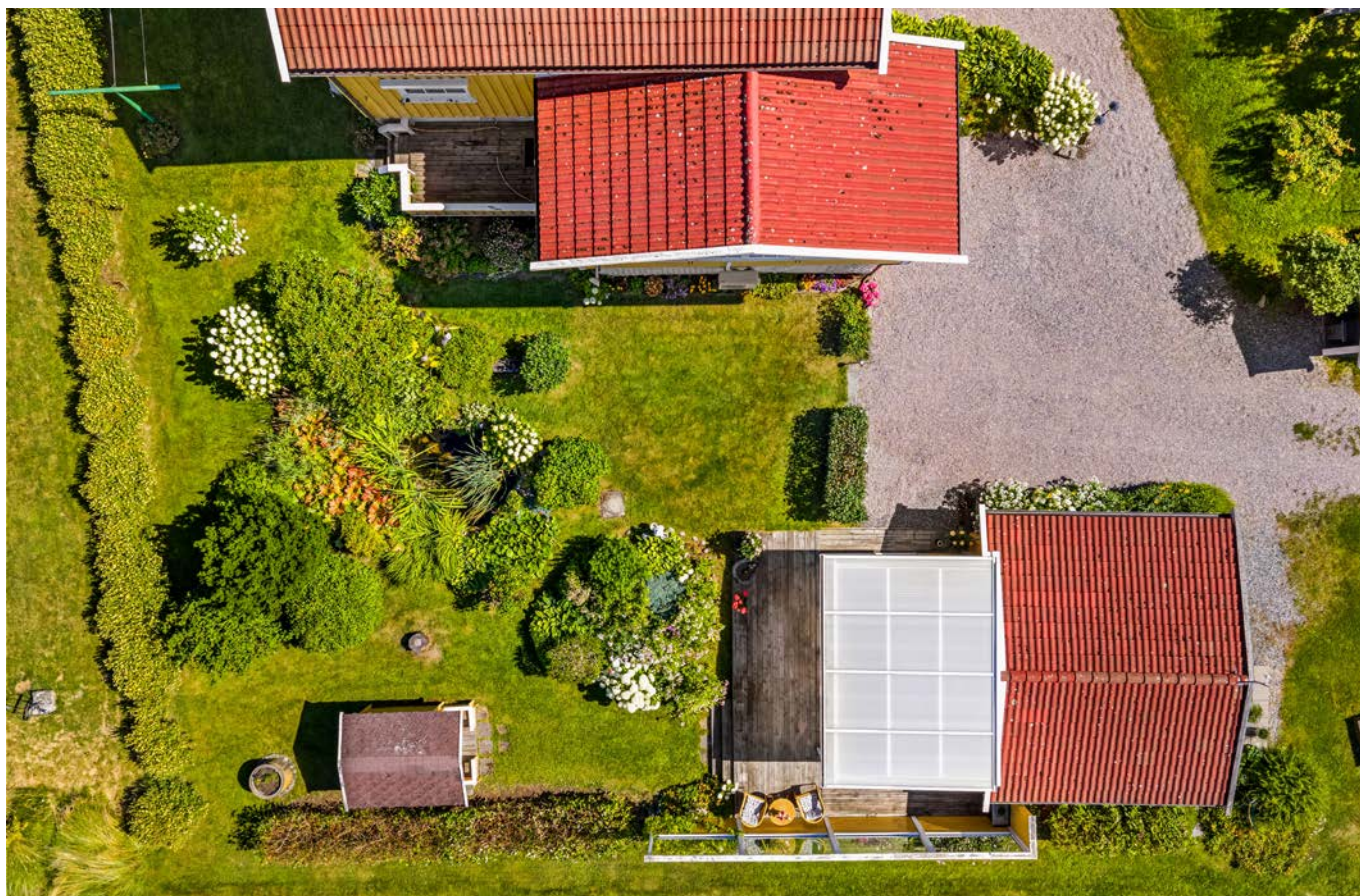
Taket er tekket med betongtakstein, skiftet i 1995.
