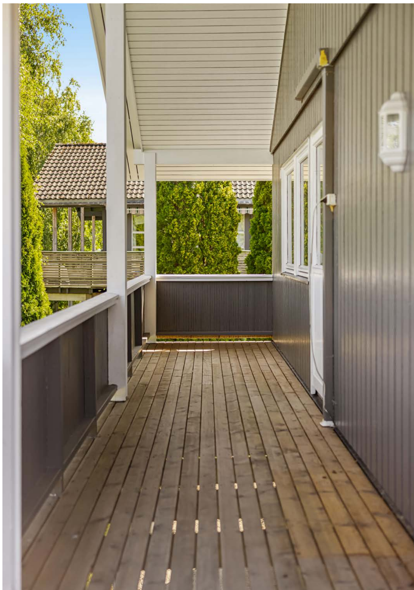
Overbygget inngangsparti ved siden av hovedinngangen.
