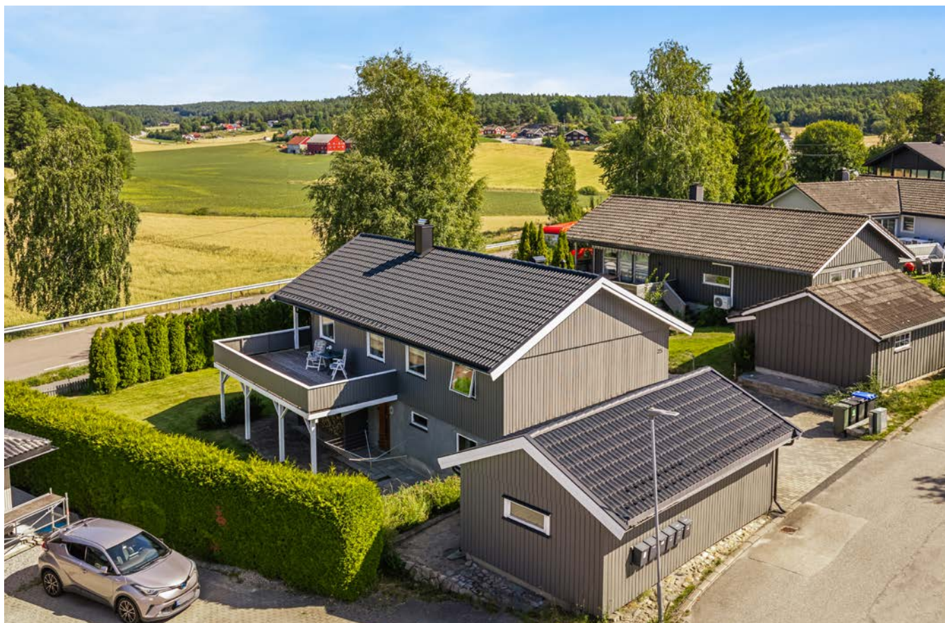
Taket er oppgradert med ny betongtakstein og pipebeslag i 2021.
