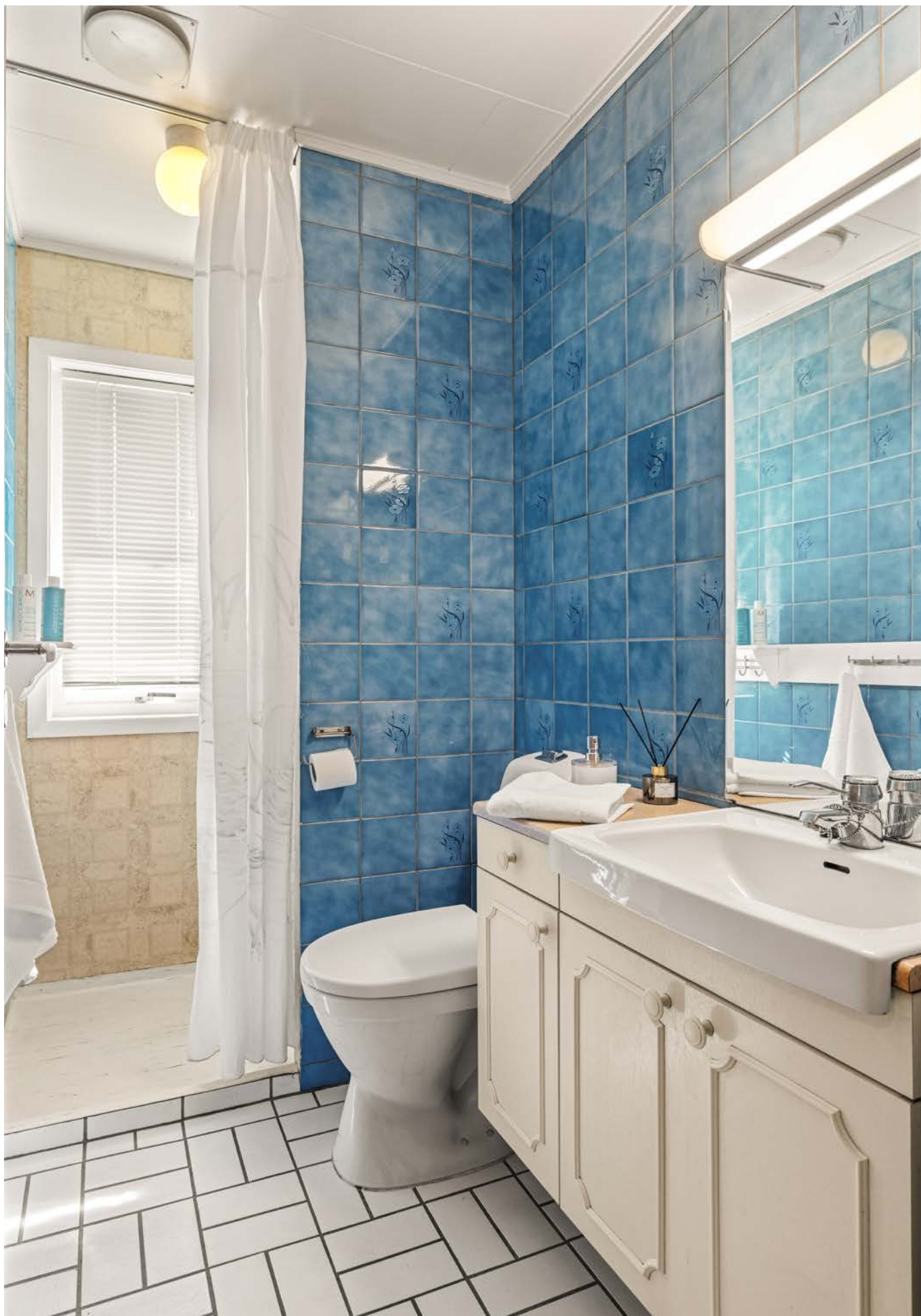
Badet i første etasje, er av eldre dato, og har avvik i forhold til dagens krav til standard. Rommets hoveddel har flislagt gulv og vegger, og det er elektriske varmekabler i gulvet. Det er utstyrt med toalett og baderomsinnredning.
