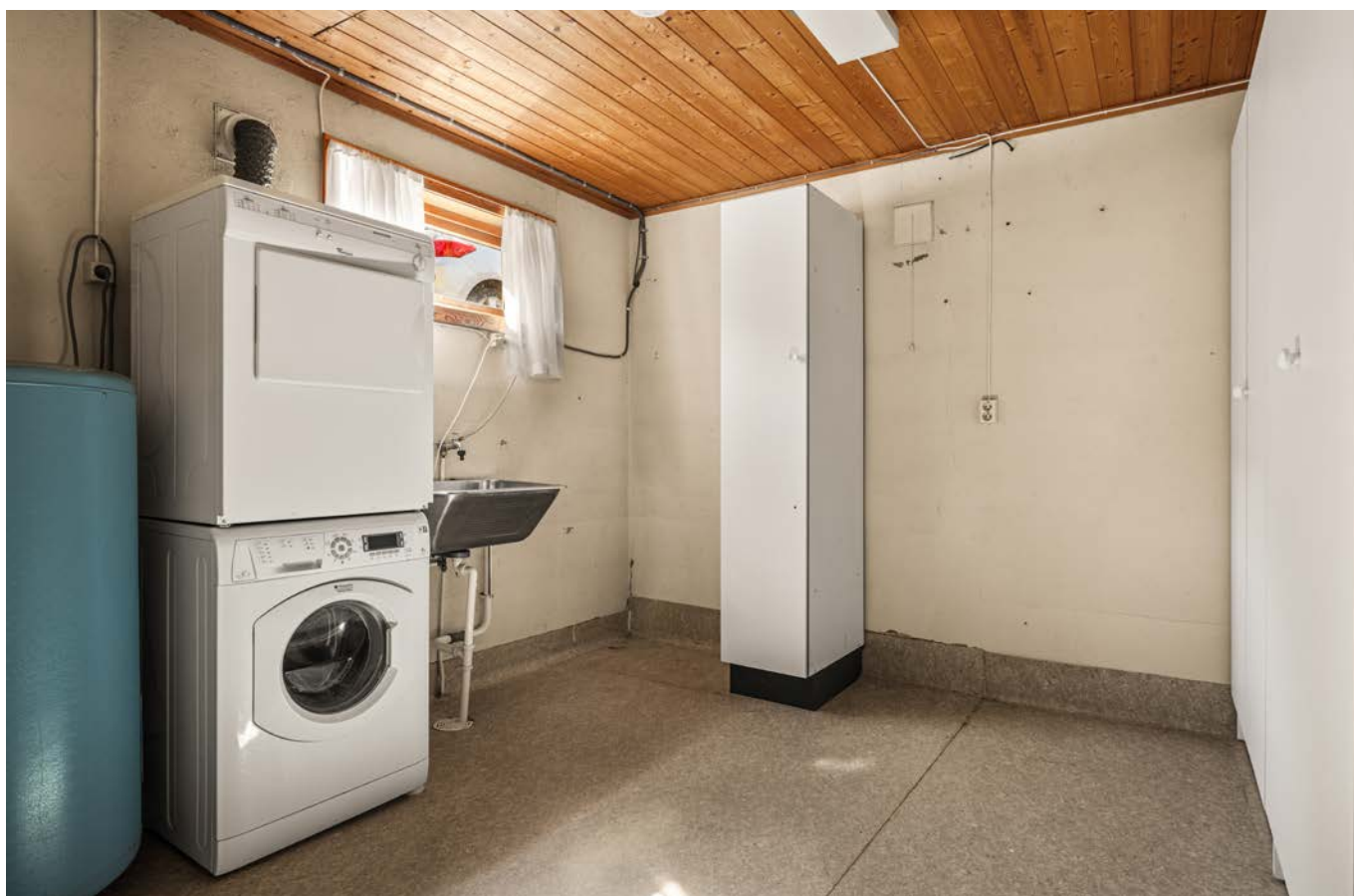
Praktisk vaskerom i underetasjen, med et oppgraderingsbehov. På gulvet er det vinylbelegg med varmekabler. På veggene er det malt puss. Rommet er innredet med utslagsvask og opplegg for vaskemaskin og tørketrommel. Skap for lagring og varmtvannstank.
