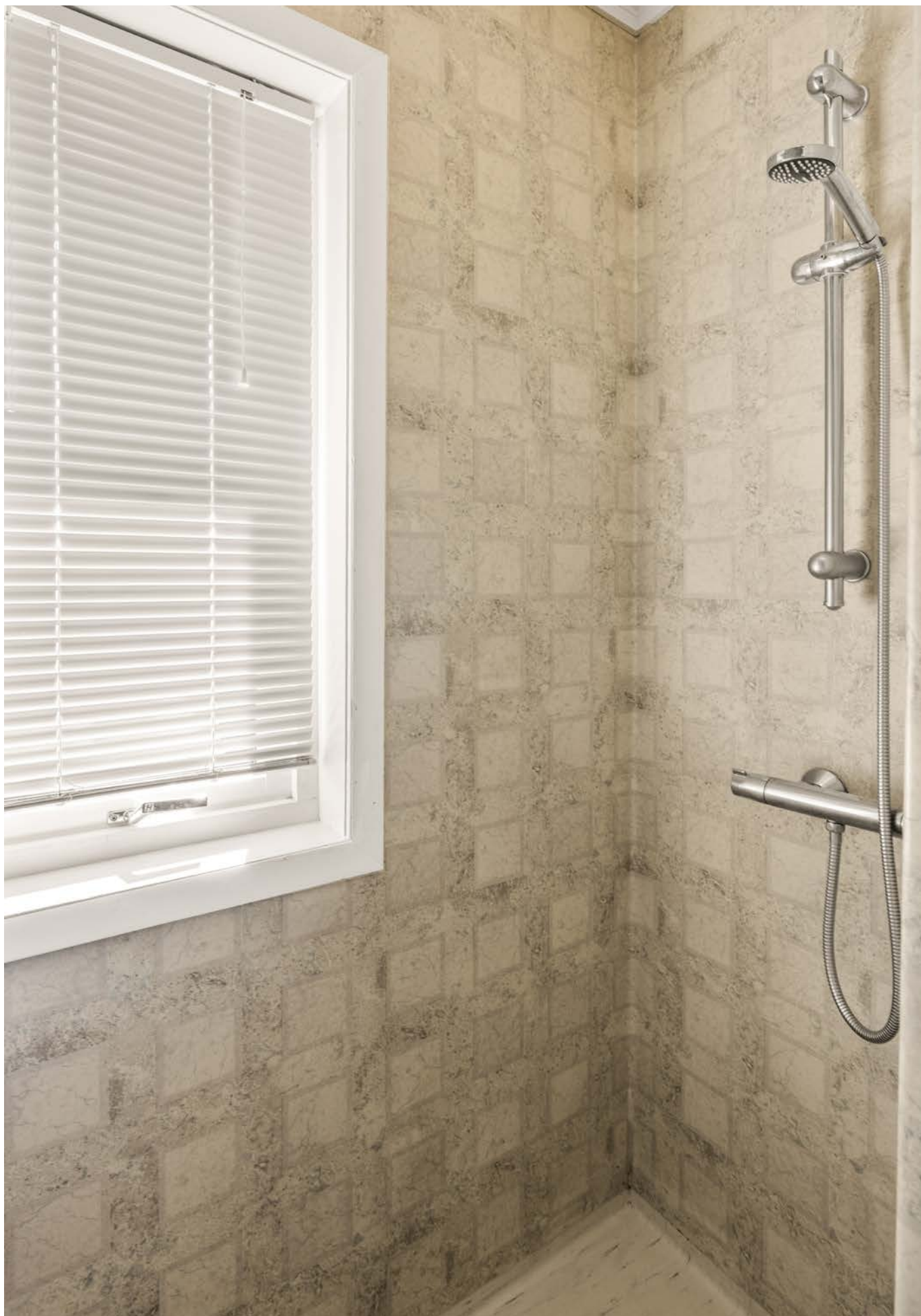
Dusjnisen er utbedret med våtromstapet på vegger og vinylbelegg på gulv.
