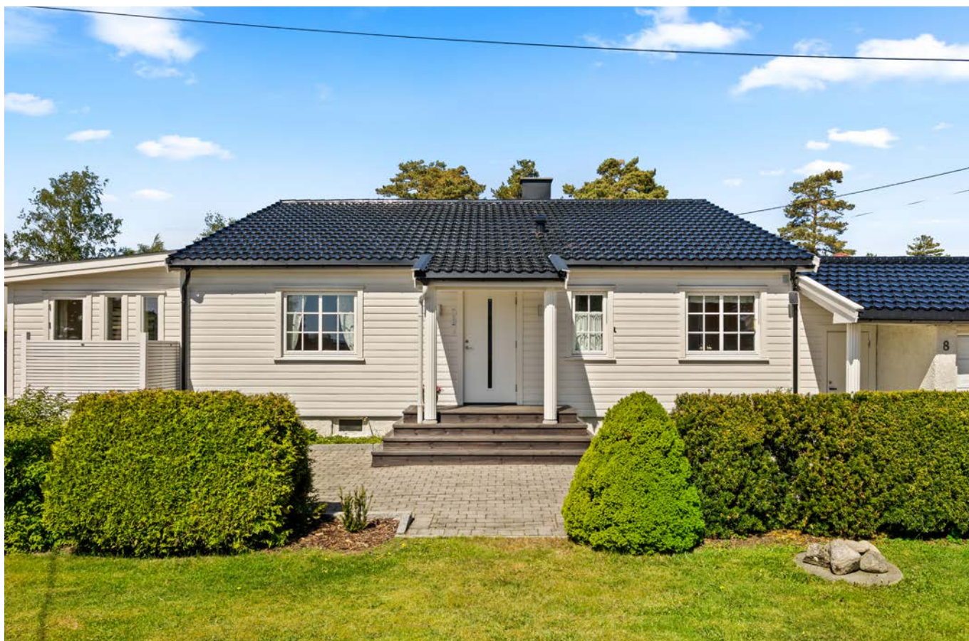
Eiendommen har liggende trekledning og tak tekket med stålplater i 2010.
