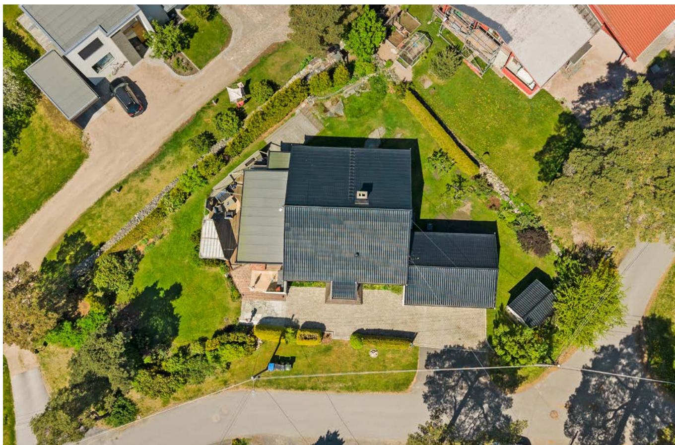
Boligen er fundamentert på fjell, som er vanlig for byggegrunnen i området.
