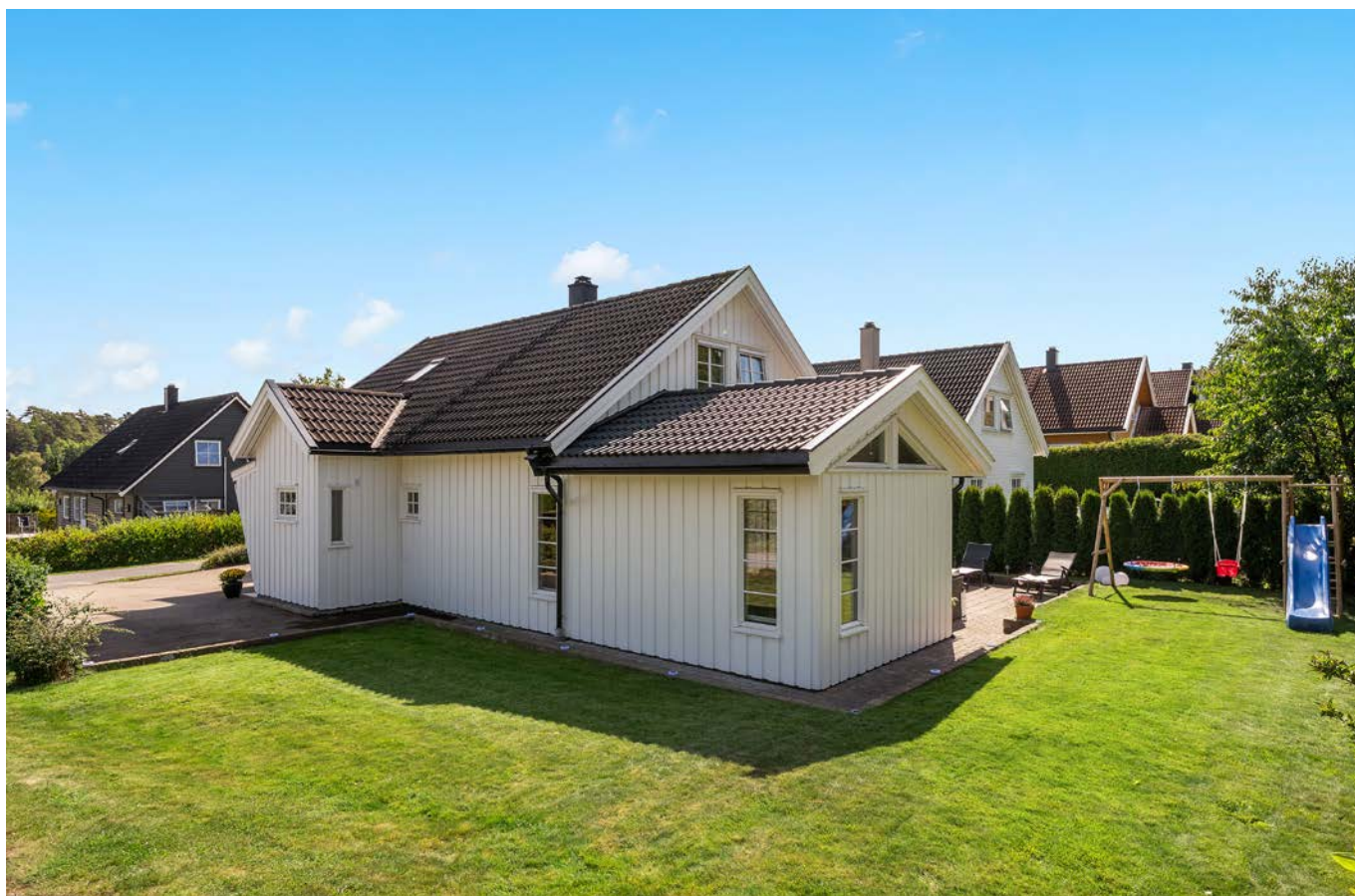
Taket er tekket med solid betongtakstein.
