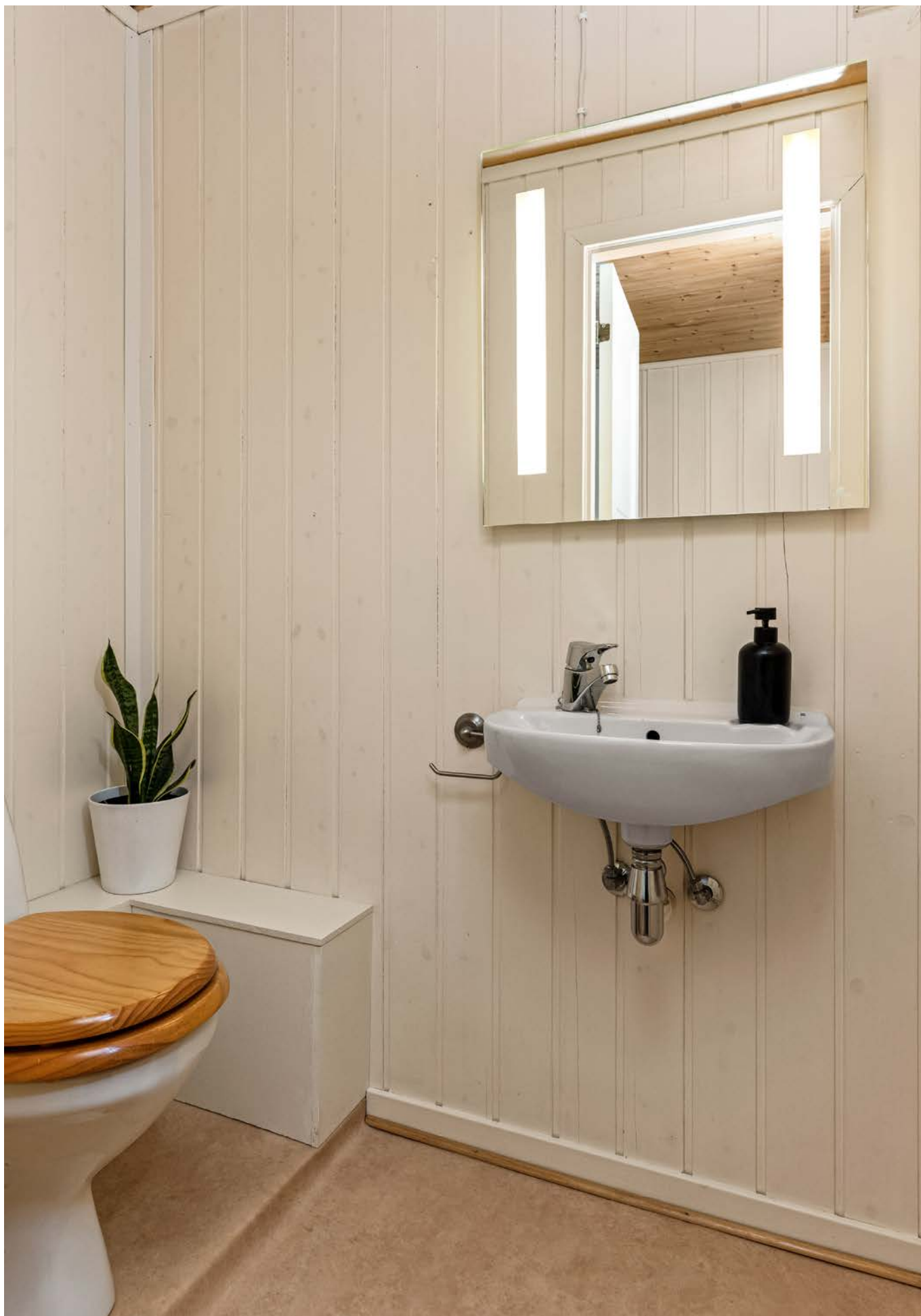
Separat WC-rom i kjelleren med vegghegt servant og gulvmontert toalett. Rommet er ikke godkjent for varig opphold.
