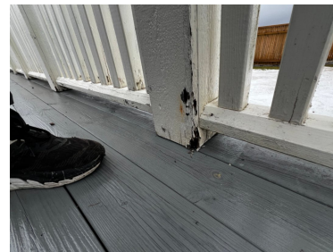
Råteskader rekkverk
