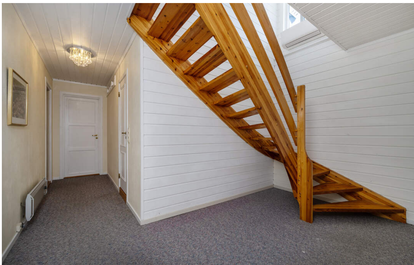
Åpen tretrapp mellom etasjene.
