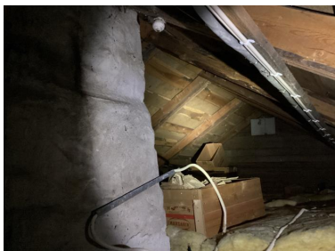
Inspeksjon utført fra loftsluke.
