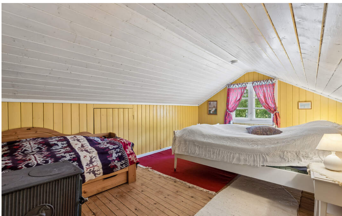
Det andre rommet på loftet har også plass til flere sengeplasser. Dette rommet er heller ikke godkjent til varig opphold. Rommet har vedovn og kneloft.
