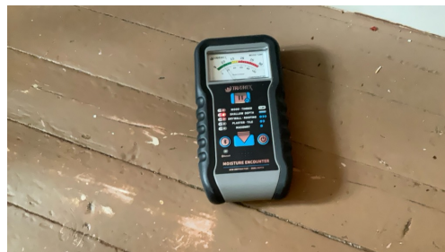
Ved fuktsøk på utsatt sted er det ikke registrert måleverdier som indikerer fukt.
