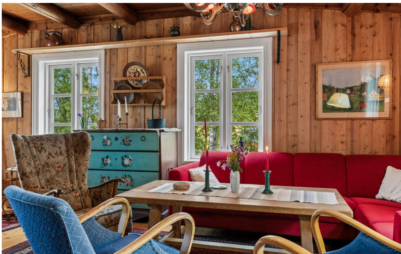
Vinduene i første etasje er i tre med 2-lags isolerglass fra 2004.
