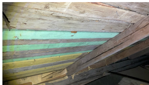
Gjenbruk av materialer i undertak.
