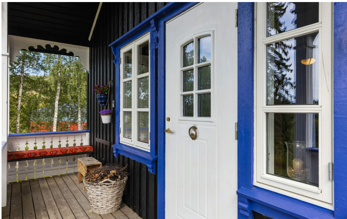
Inngangsdøren er en platedør med glassfelt, og vinduene er fra 2004.
