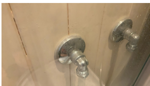
Rørgjennomføringer.
