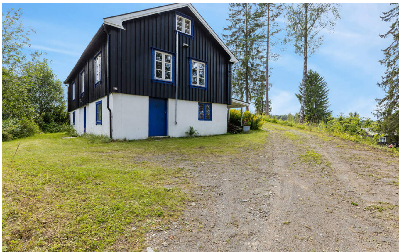
Gruset gårdsplass med adkomst til boligen og egen kjellerinngang.
