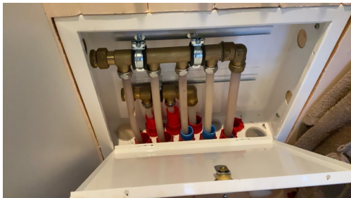
Samleskap for rør-i-rør opplegg.
