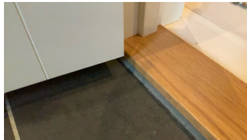
Tilluft fra spalte i dør.
