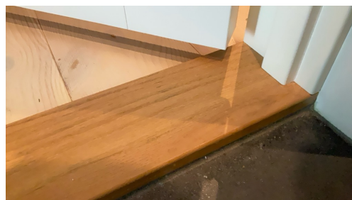
Tilluft fra spalte i dør.
