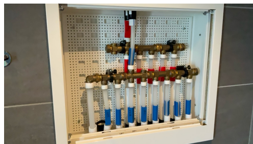
Samleskap for rør-i-rør opplegg.
