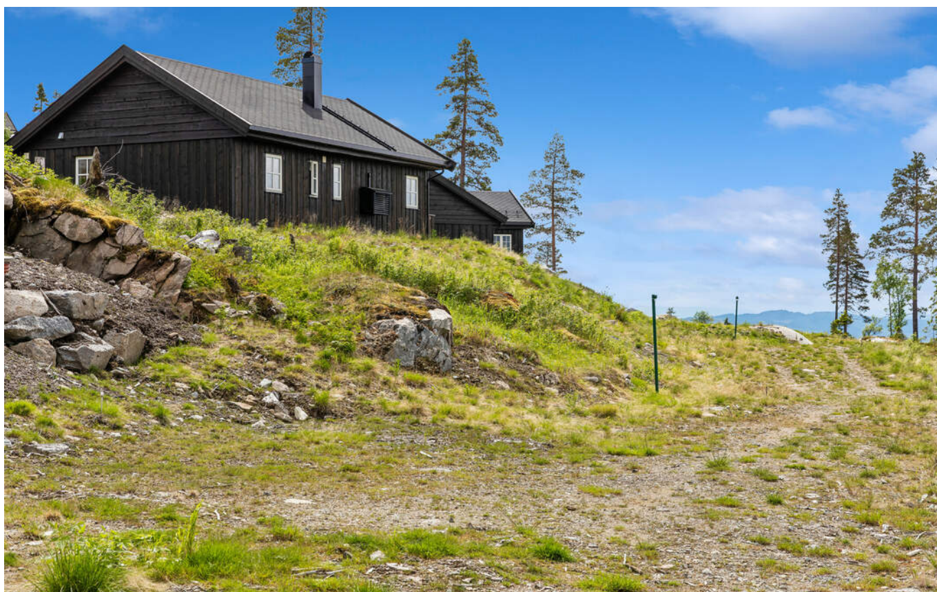
Eiendommen har umiddelbar nærhet til Lygna-området omfattende nettverk av ski- og turløyper. Rett nedenfor hytta starter løypenettet.
