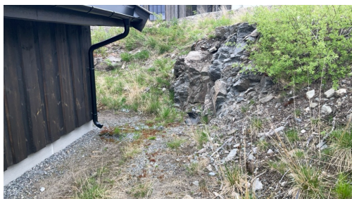
Terreng mot bygget
