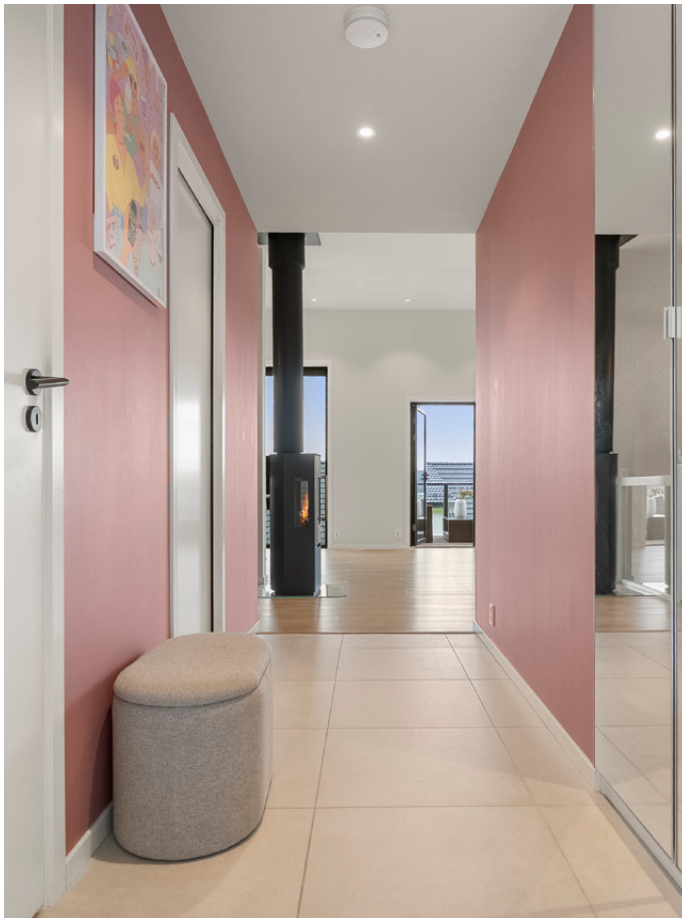
Termostatstyrte varmekabler på gang og bad. Ildsted med vedovn og stålrør i stue.
