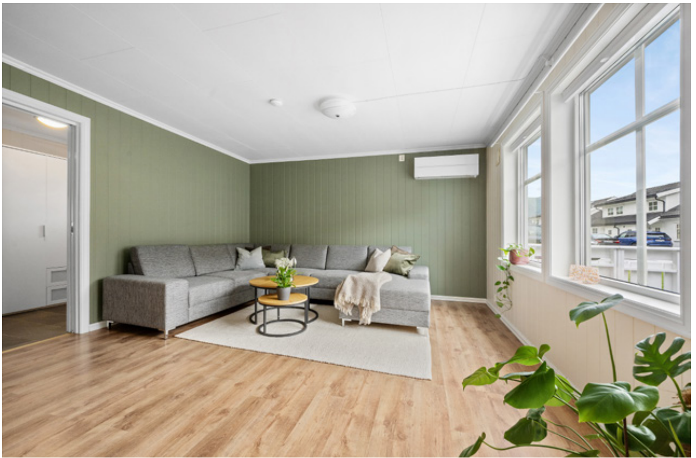
Luft-til-luft-varmepumpe frå 2018 sørger for effektiv oppvarming.
