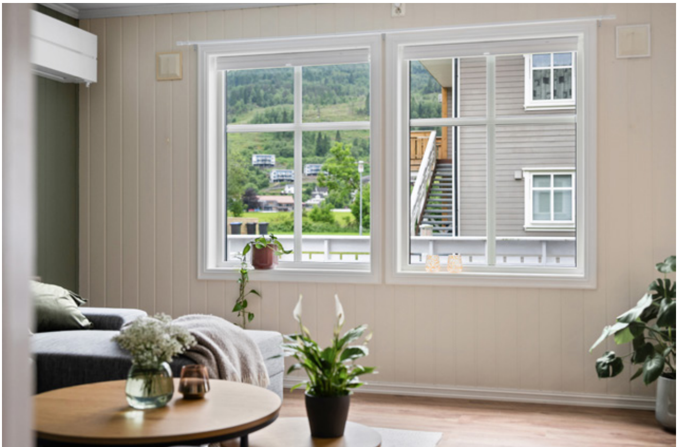
Vindauga er frå byggeåret og har måla tre-karmar.
