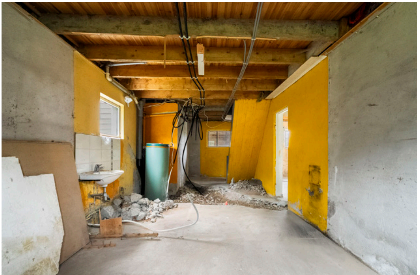
Kjellaren har eit stort areal som er klargjort for vidare arbeid.
