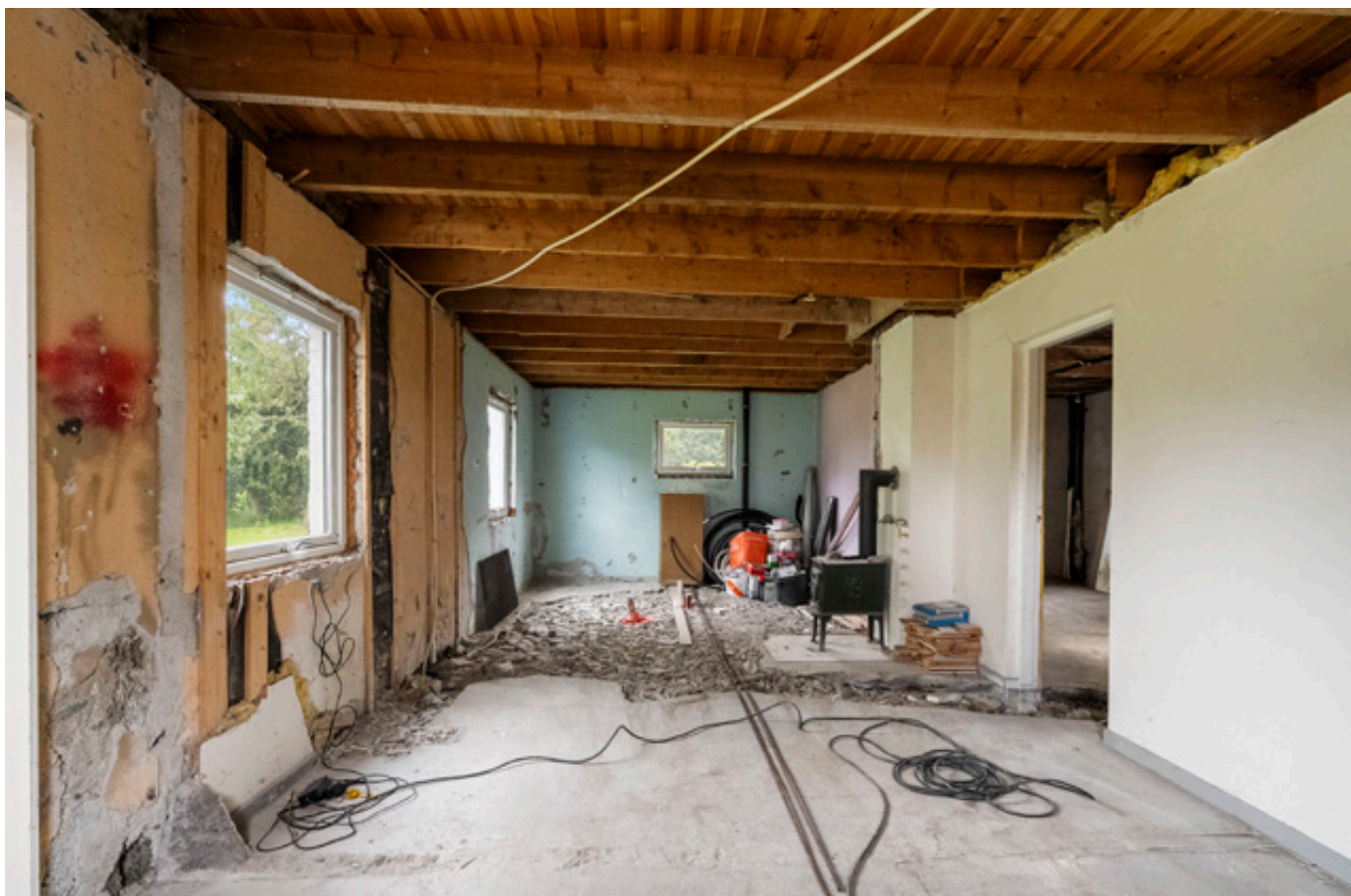
Kjellaren er under renovering og gir store moglegheiter for ny eigar.
