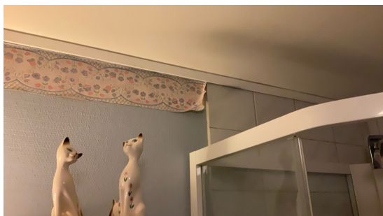
Flussing av tapet/bord.
