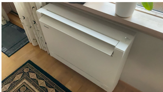
Varmpumpe innedel.
