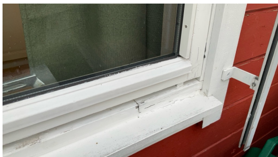
Byttet del av underkarm.
