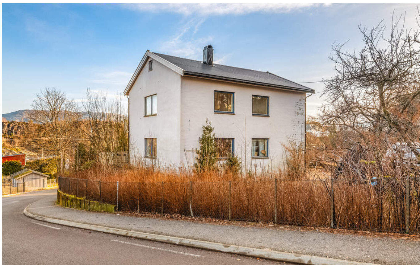
Florvågbakken et veletablert boligområde i Florvåg på Askøy. Herfra kan man spasere til skole, barnehage, busstopp, idrettsplass og butikker.
