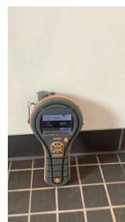
Dusjsone, vegg med dusjarmatur
