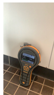
Dusjsone, vegg uten dusjarmatur
