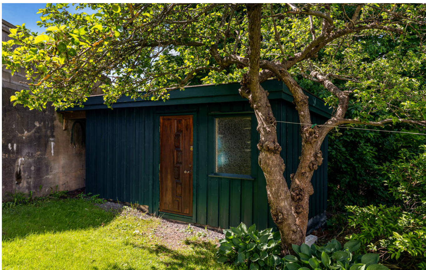
Frittstående uthus på ca. 11 m 2 gir rikelig med lagringsplass for hageredskaper og utstyr.
