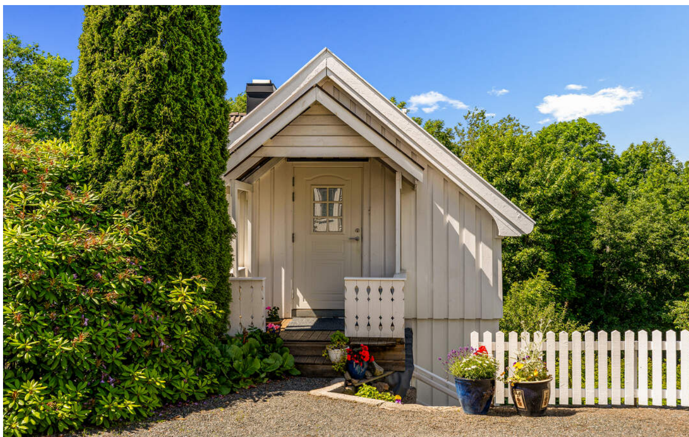
Boligen har egen inngang til andre etasje via utvendig trapp.
