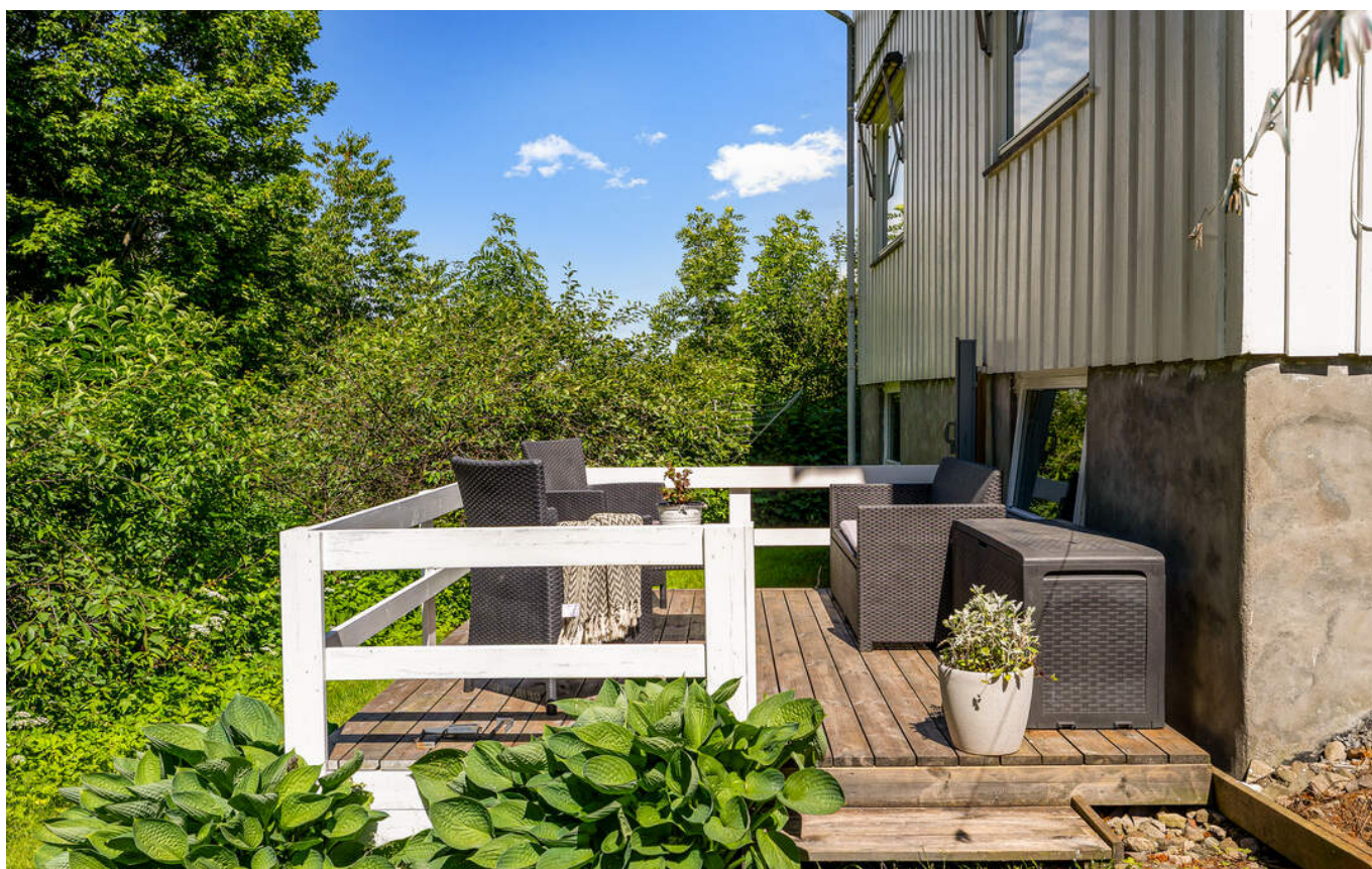
Uteplassen er bygget i trekonstruksjon og har god plass til utemøbler.
