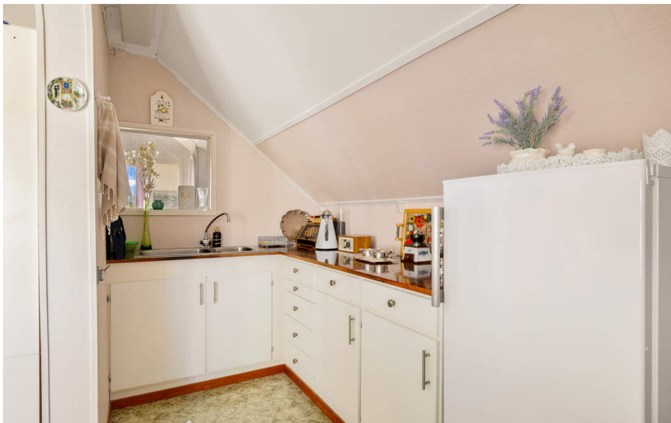
Kjøkkeninnredning med slette fronter og laminat benkeplate.
