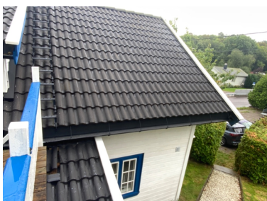
Tak over inngangsparti uten snøfangere
