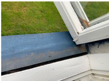
Vannbrettløsning uten besla
