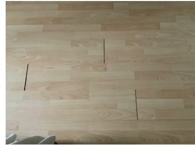
glipper i laminatgulv
