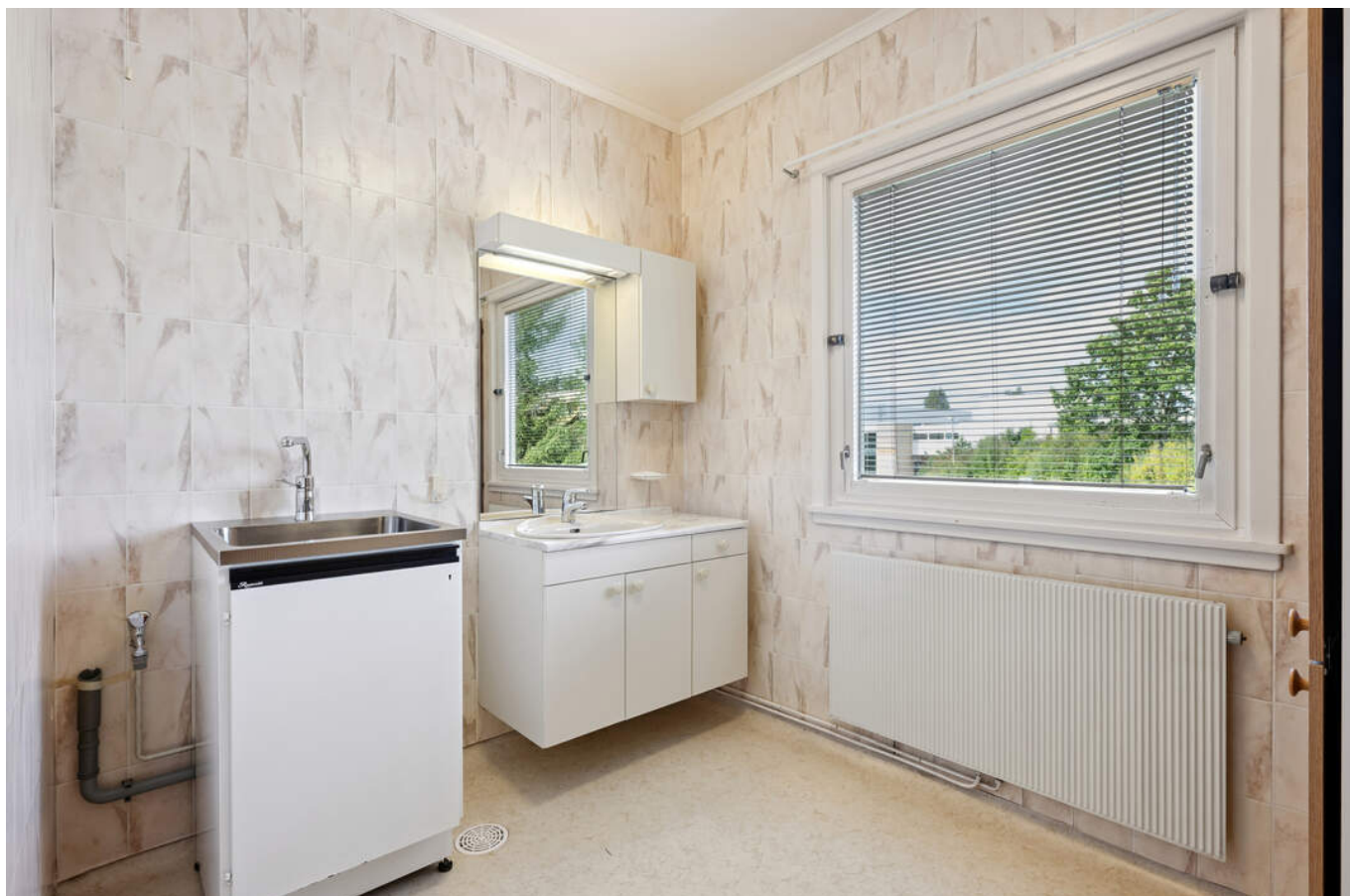
Vaskerom med belegg på gulv og våtromstapet, servant og skap. Utslagsvask
