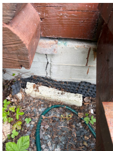
Sprekk i fundament til veranda
